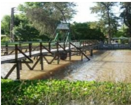
Foto N° 2: Puente peatonal tendido sobre el canal Villanueva, une las localidades de Dique Luján y Villa La Ñata. Hasta 2009 era el único puente que conectaba Dique con el resto del Partido de Tigre.
