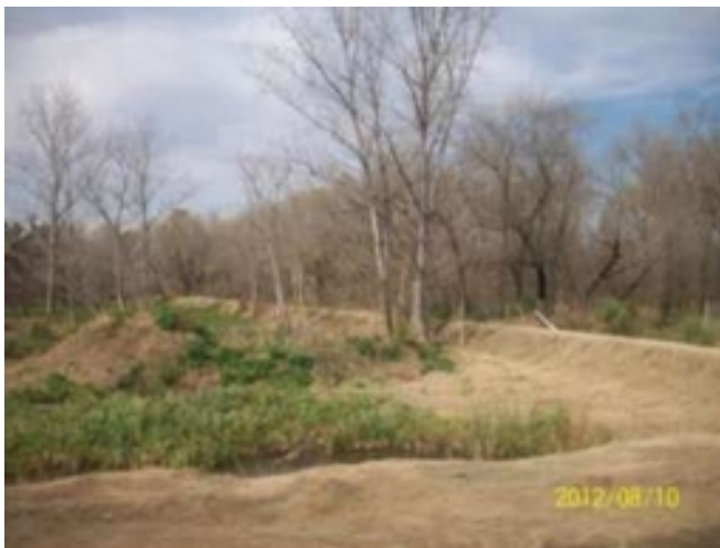
Foto N° 35: terraplén construido sobre calle España, actúa defensa lateral del pueblo, este endicamiento protege principalmente al Barrio Rialto de los desbordes de los arroyos Garín y Canal Pacheco, del Partido de Escobar.
