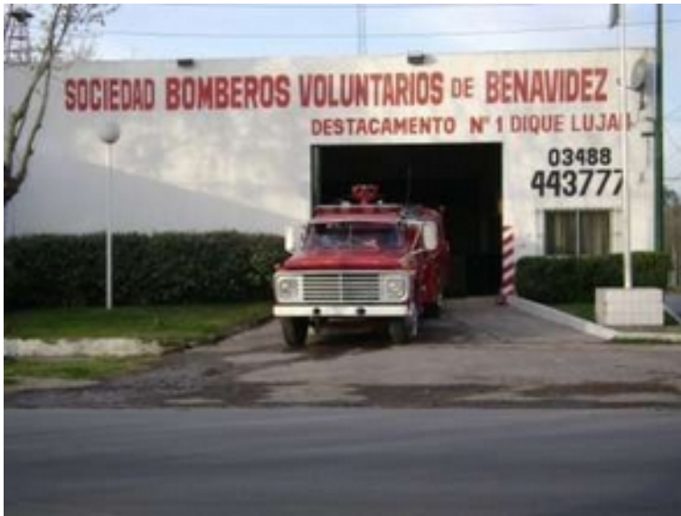
Foto N° 41: Actual Destacamento N°1 Dique Luján, ubicado sobre Av. 12 de octubre.
