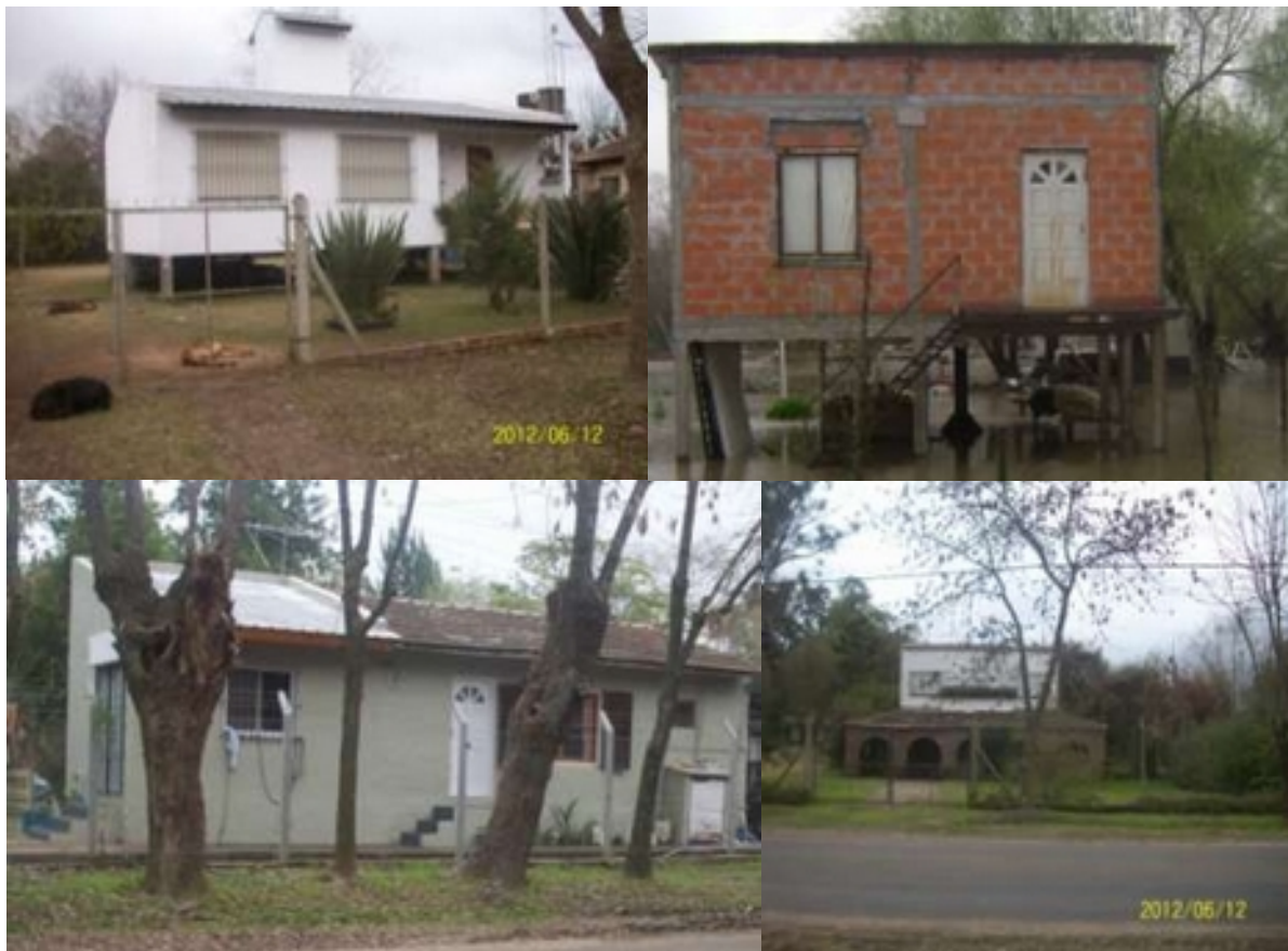
Fotos N° 24, 25, 26 y 27: Distintas técnicas de construcción de la zona, casas edificadas de alto, sobre pilotes (arriba) y casa con base elevada, (abajo izquierda) y casa con planta baja destinada a usos no permanentes, galería, garaje (abajo derecha).
