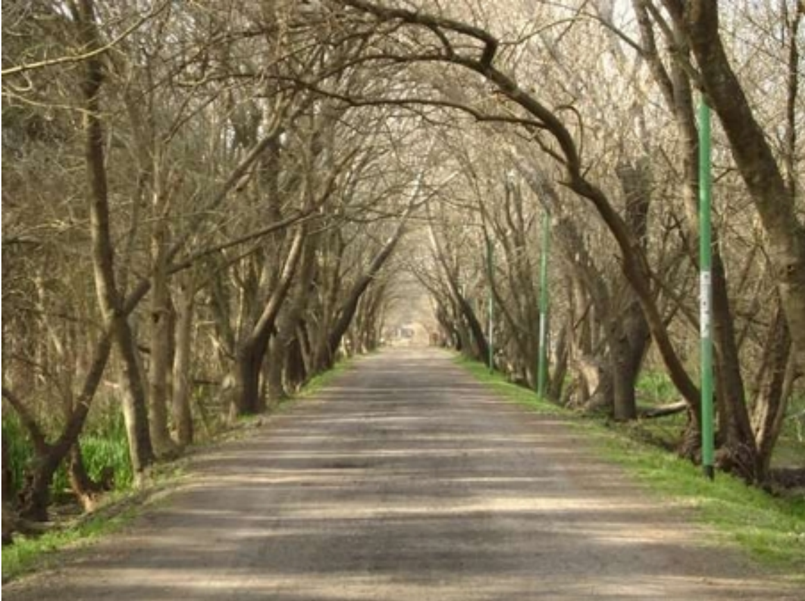
Foto N° 17: Terraplén antigua vía del Ferrocarril Central Argentino, denominado “vía muerta” por los lugareños. Utilizado como camino de servicio, hasta la calle Brasil (límite con el Partido de Escobar) y luego hasta la ruta N° 26, donde se podía abordar el colectivo de la línea 291.
