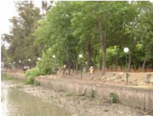
Foto N° 23: Tablestacado y terraplenes sobre Canal Villanueva (2005). Fotografía tomada durante el inicio de obras de construcción de Paseo de Artesanos sobre la costanera del Canal Villanueva, el 12/01/09.
