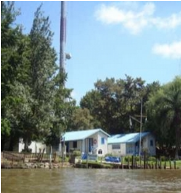
Foto N° 42: Prefectura Naval Dique Luján, ubicada sobre río Luján y Canal Arias, es en este puerto que se mide la altura del río Luján y se establecen los estados de alerta y evacuación.
