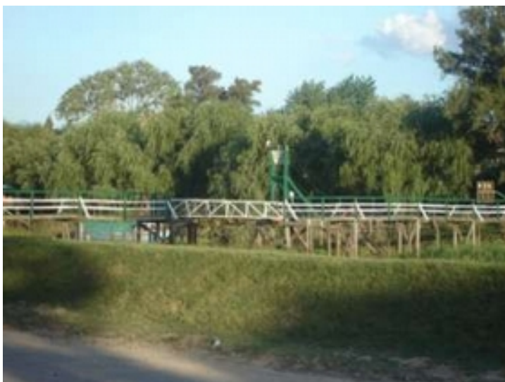
Foto N° 38: Terraplén bordeando canal Villanueva. “Los de la costa del Villanueva no fue tan complicado, en algunos lados ya estaba pero muy bajito, fue un impacto para la gente del pueblo, tener que acostumbrarnos ver la costa a través de un montículo de tierra” (Vecino)
