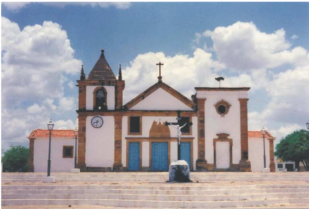
Figura 2.3 – Igreja de Nossa Senhora da Vitória, catedral de Oeiras. A edificação iniciada em 1733 é típica da arquitetura austera dos jesuítas. Foi executada parceladamente, pois recebeu apenas uma das torres do par previsto. As pilastras, frisos, portadas e as junções em ângulo são esculpidas em arenitos vermelhos do Devoniano local.
