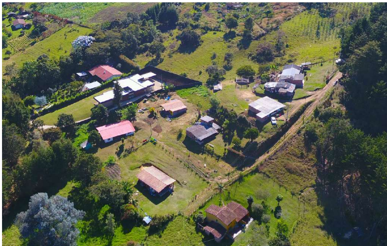
Imagen 25. Vista aérea de los predios de la AME Nucleada (PK 292).
