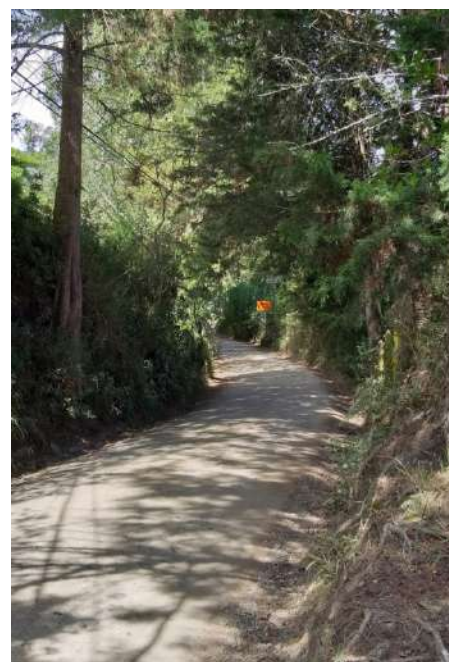
Imagen 57. Sección típica de las vías terciarias que permiten el acceso al polígono, anterior a la reciente intervención de pavimentación. Fuente: Vías y Tránsito.
