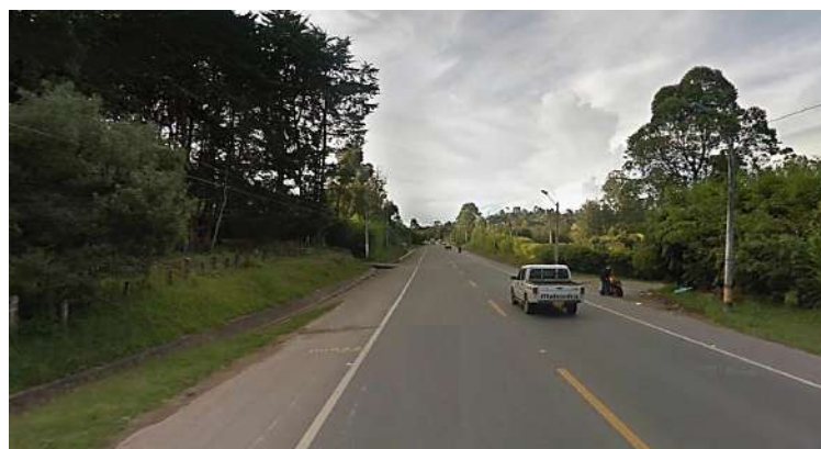
Imagen 56. Aspecto de la sección y estado actual de la vía La Mosquita - Aeropuerto José María Córdoba. Fuente: Vías y Tránsito.
