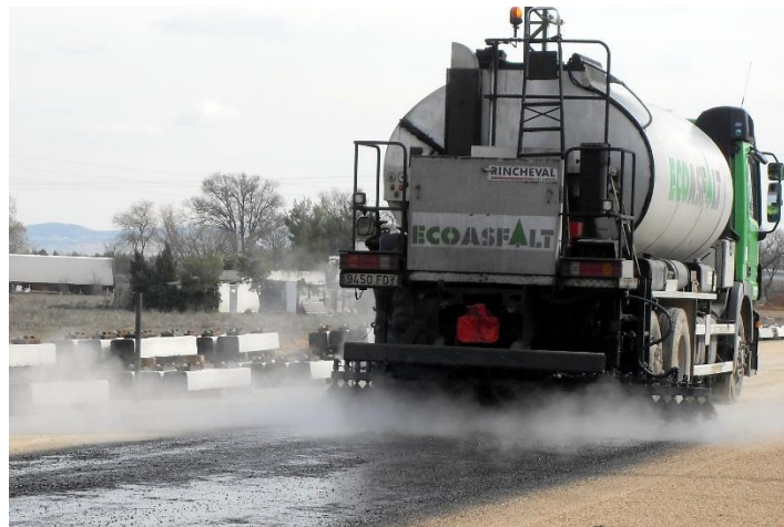
Ilustración 41 extensión de emulsión asfáltica Fuente: (EcoAsfalt s.f.)
