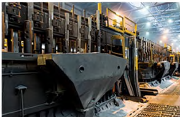
Рисунок 11 – системы автоматической подачи глинозема на Красноярском алюминиевом заводе
