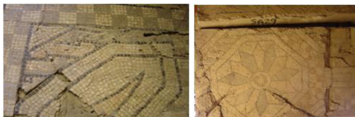
Fig 6 (a e b) – Aspectos de dois painéis do mosaico, que mostram a desagregação do tessellato.
