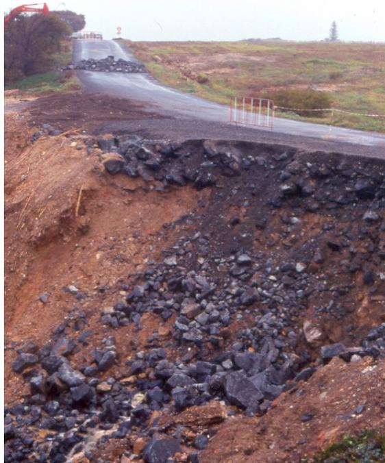
Nos anos posteriores à construção do CM 1109, os valores de pluviosidade registados (inferiores aos normais) implicaram o adiamento deste tipo de problemas até ao final da década de 90, altura em que valores normais de pluviosidade provocaram a obstrução das condutas, o colapso de alguns troços da estrada (sobretudo junto a Porto Côvo) e de pequenos caminhos de terra batida, sob os quais as linhas de água torrenciais se encontravam
