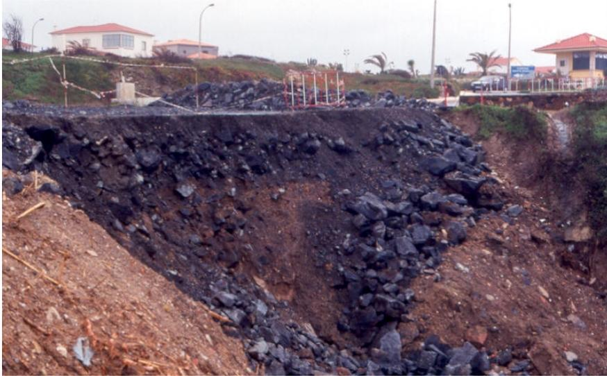
**Figura VI.16 - CM 1109 junto a Porto Côvo. Abatimento da estrada por colapso do aqueduto em Dezembro de 2000 (B)**
