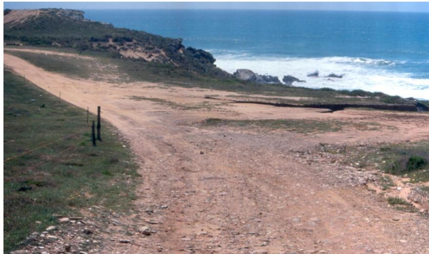
**Figura VI.15 - CM 1109 junto a Porto Côvo. Abatimento da estrada por colapso do aqueduto em Dezembro de 2000 (A)**
