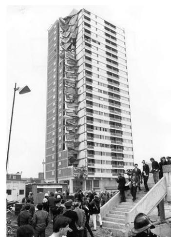
Figura 8.1 – Edifício Ronan Point após colapso (Menchel, 2009)
