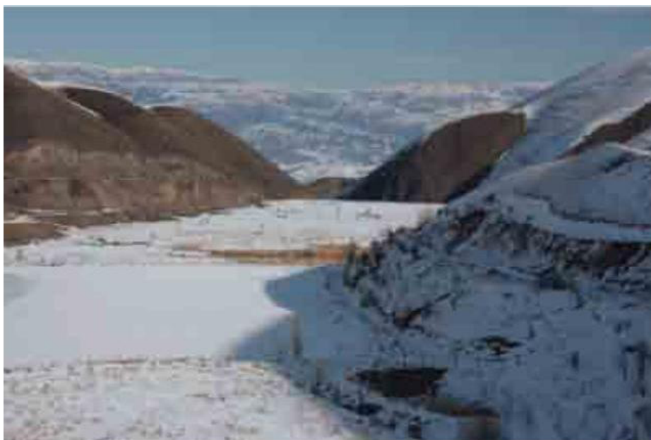
Бурдинское хвостохранилище в районе поселка Орловка
