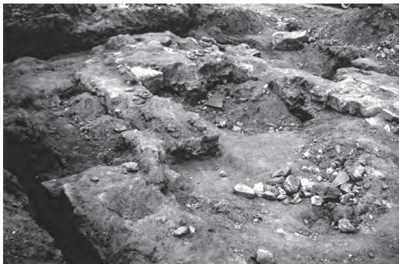
Estat de conservació de l'edifici el 1962. Observeu com la connexió entre capçalera i nau es trobava molt malmesa (Arxiu de Sant Feliu de Guixols, fons Esteva)
