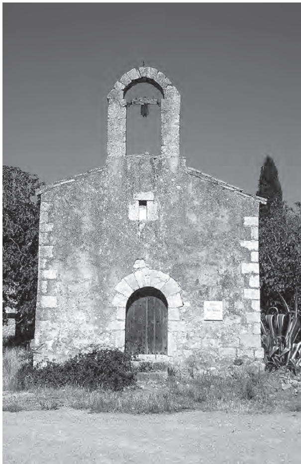
Santa Reparada. Vista frontal abans de la restauració
