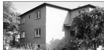
RACIBÓRZ dom o pow. 196m 2 , piętrowy, podpiwniczony. PARTER-4 pok. kuchnia, łazienka. PIĘTRO(stan surowy zamknięty)-4 pok. kuchnia, łazienka. Okna PCV, CO-węgiel (nowy piec). Dach kryty papą. Działka 17a. - 215tys zł. Dodatkowo działka 21a pod zabudowę usługową - 75 tys zł
