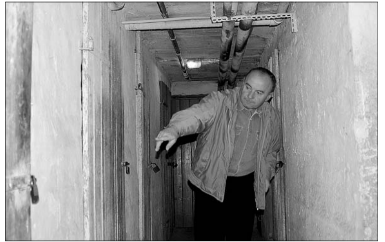
Edward Szczygielski w piwnicy pokazuje miejsce, w którym zamontował dodatkowe drzwi
