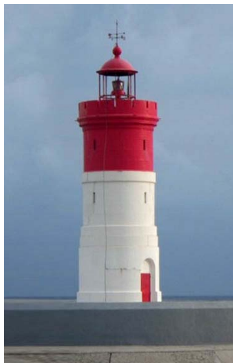
Dique de Navidad Light
