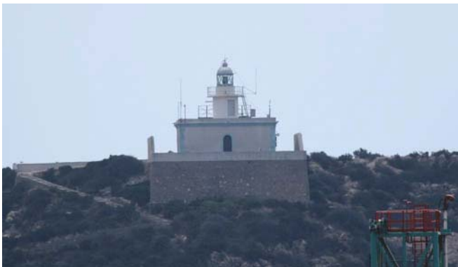
Isolete de Escombreras Light
