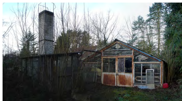
Abb. 09 Blick nach Norden in das nordwestliche Plangebiet mit dem aufgegebenen Gewächshaus
