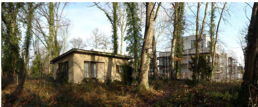
Abb. 06 Blick von der Straße Am Petzinsee in das südöstliche Plangebiet mit der benachbart entstehenden Wohnbebauung
