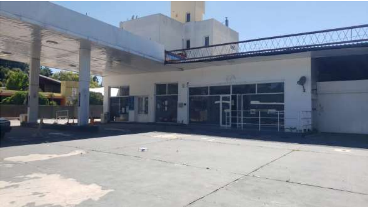
Imagen 11 Estado actual de la EESS
