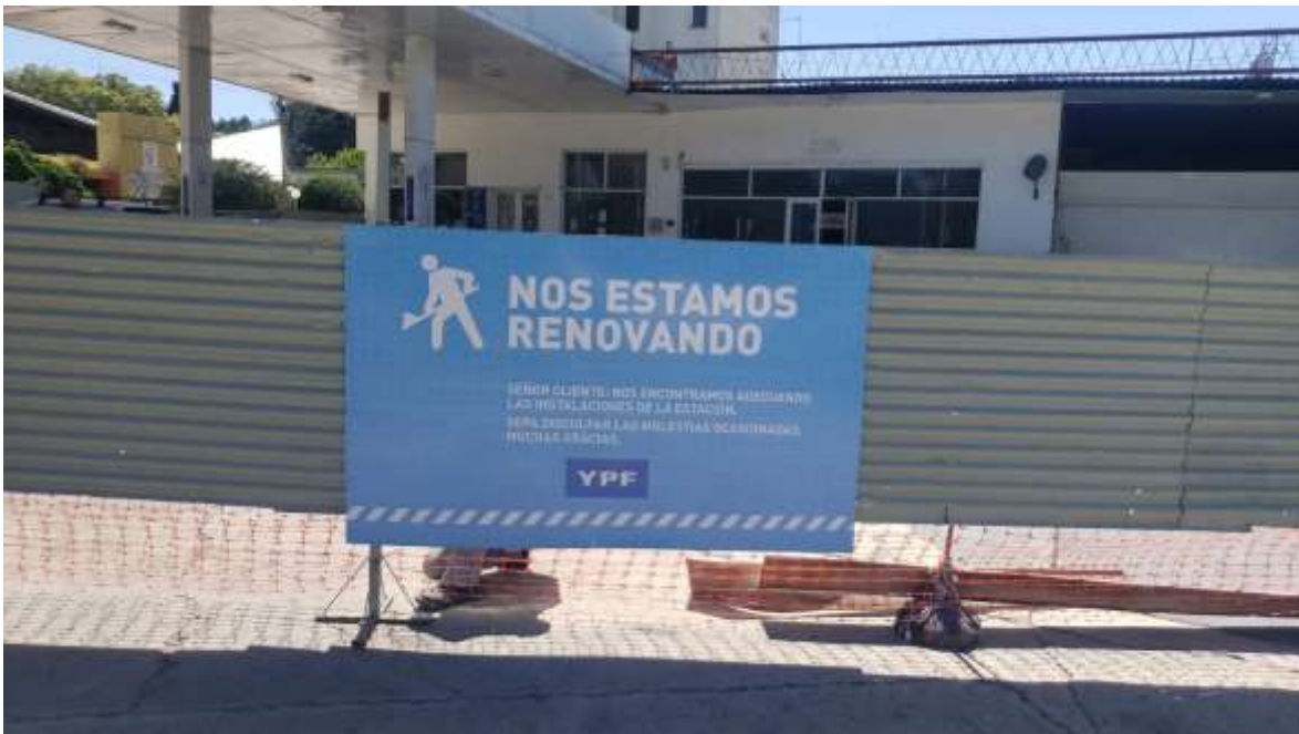
Imagen 9 Estado actual de la EESS
