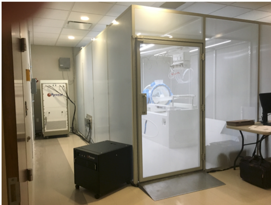
Figura 8.1. Sala de tratamiento apantallada. Nótese como el puesto de control se encuentra fuera de la sala de tratamiento, a la derecha de la puerta.
