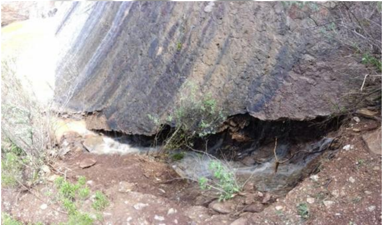
PERDIDA DEL BASAMENTO DEL SUELO NATURAL
