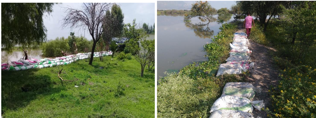
Comunidad El Carmen (Arroyo Seco) y Comunidad Pintores (Río Turbio), elevando con costalera las márgenes de cuerpos de agua.
