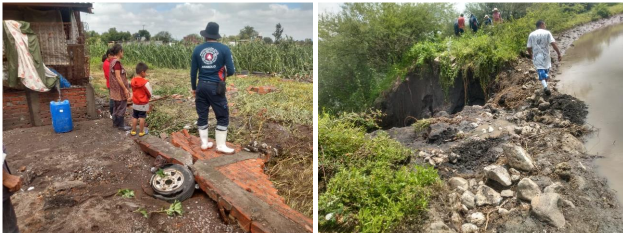
Daños en viviendas y bordo rural. San Lorenzo.
