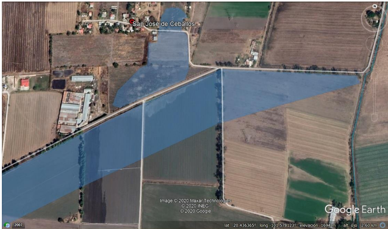
Zona afectada con encharcamiento en patios de viviendas y zona de cultivo, Comunidad San José de Ceballos.
