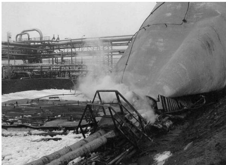
Fot. 7. Deformacja zbiornika ZM3.
