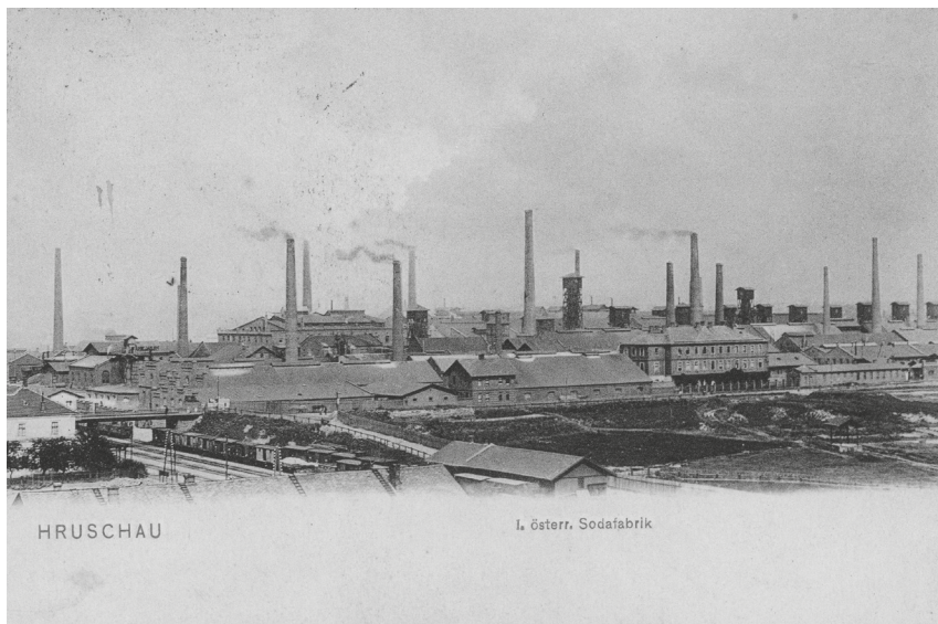
Obr. 1. Továrna na sodu v Hrušově (1908)
