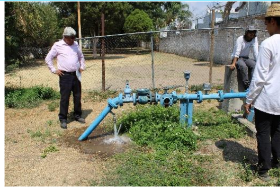
Purga del pozo
