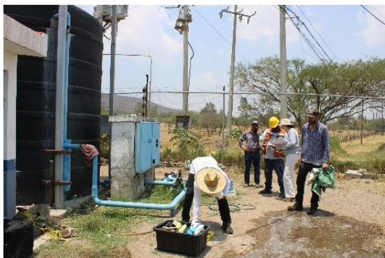
Medición del nivel dinámico
