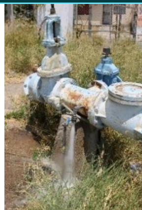
Purga del pozo
