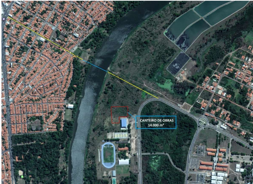
Figura 4. Localização das obras. (Fonte: PCA Engenharia 2018).
