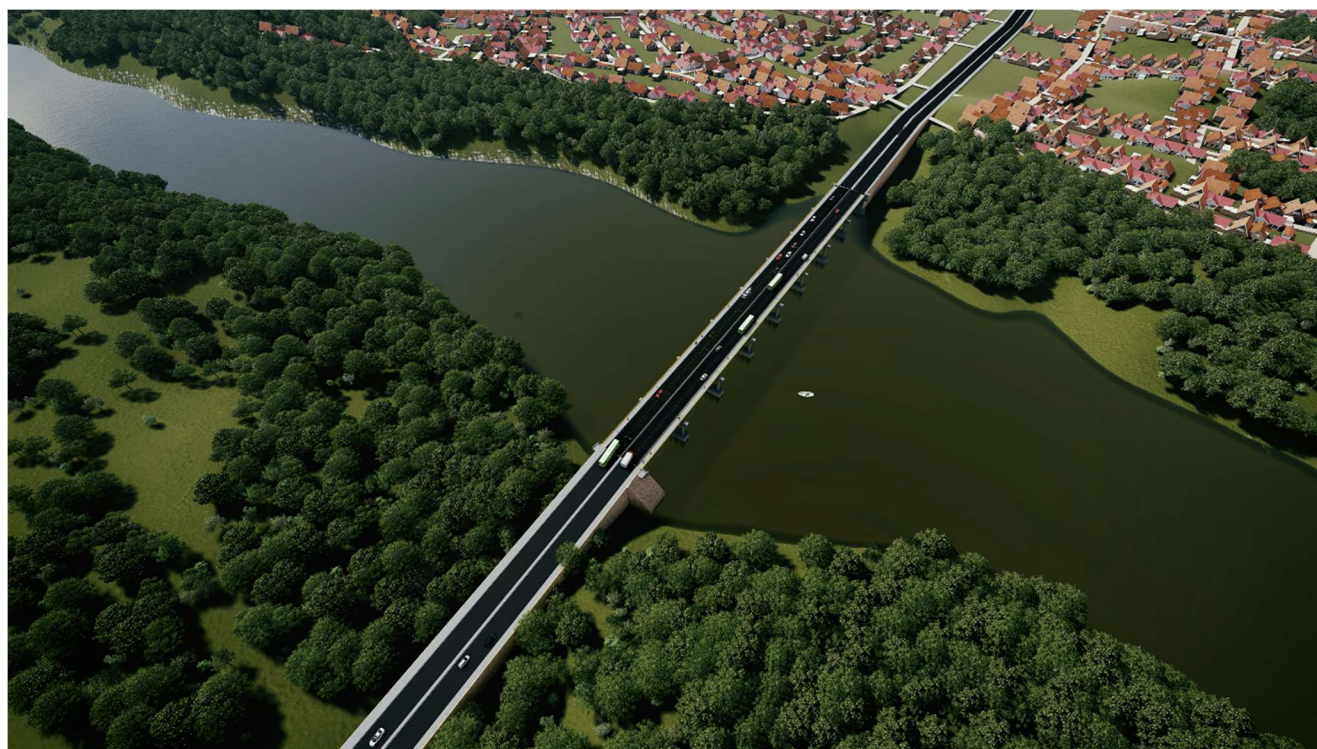
Figura 1: Ponte da Universidade. (Fonte: PCA Engenharia 2018).
