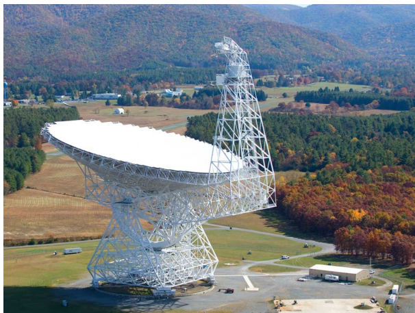
Obrázek 7.5: Radioteleskop Green Bank (GBT) s plně pohyblivou parabolickou anténou o rozměrech 110 krát 100 m. Jedná se mimoosové Gregoryho uspořádání, nahoře na rameni je tedy elipsoidální sekundární reflektor a záhy pod ním „místnost“ s vícero přijímači. Dalekohled je vybaven aktivní optikou, tzn. 2 209 aktuátory pod primární anténou a šesti laserovými dálkoměry nad místností, kterými se měří vzdálenosti od instalovaných optických retroreflektorů, což v uzavřené smyčce určuje požadovaný tvar i (konfokální) polohu sekundáru (Wells 2000). Převzato z https://public.nrao.edu/explorer/gbt/TheGBTExplorer.php .
