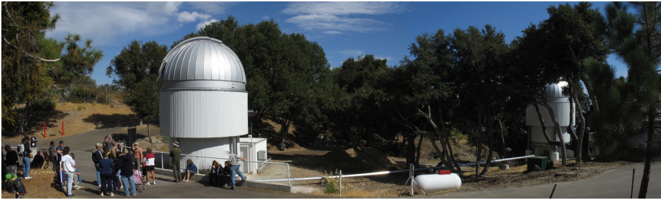
Obrázek 5.24: Dva ze šesti 1metrových dalekohledů interferometru CHARA na observatoři Mount Wilson. V dolní části snímku je vidět evakuovanou trubici, kterou je světlo vedeno ke zpožďovací dráze (vlevo, nezobrazena).
