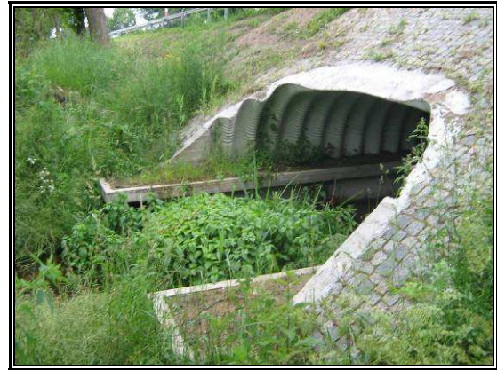
Fot. 11.11 Przykład wykonania suchych półek umożliwiających migrację małych zwierząt oraz płazów
