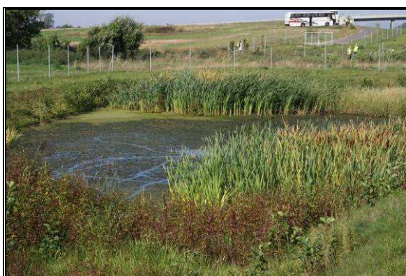
Fot. 11.1 Przykład obrosniętego roślinnością zbiornika retencyjno-infiltracyjnego przy autostradzie A2
