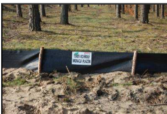
Fot. 11.6 Przykład wygradzenia placu budowy autostrady A2 przed migrującymi płazami [129]
