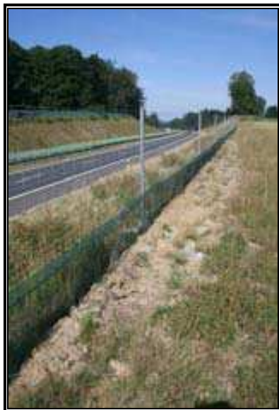
Fot. 11.16 Przykład ogrodzenia ochronnego (droga ekspresowa S1) [126]
