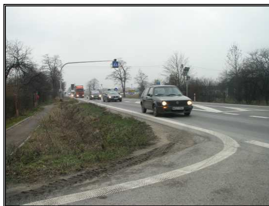
Fot. 2.2 Istniejąca droga krajowa Nr 7 w rejonie Orońska
