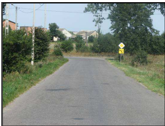
Fot. 4.12 Widok na zabudowę w Orońsku z istniejącej drogi powiatowej
