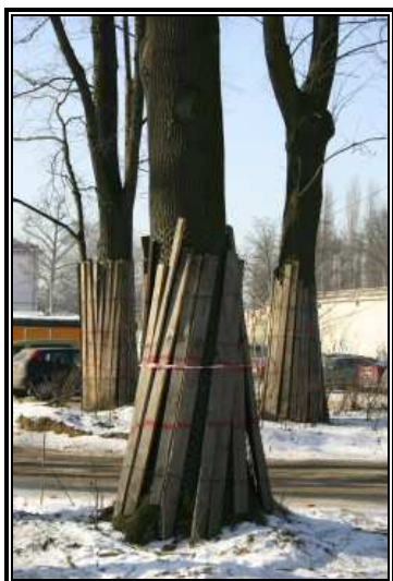
Fot. 11.4 Przykładowy sposób ochrony pnia drzewa przed uszkodzeniami związanymi z pracami wykonywanymi w jego pobliżu [122]
