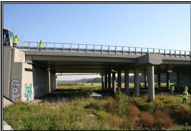
Fot. 11.8 Przykład przejścia dolnego dla dużych zwierząt (autostrada A2)
