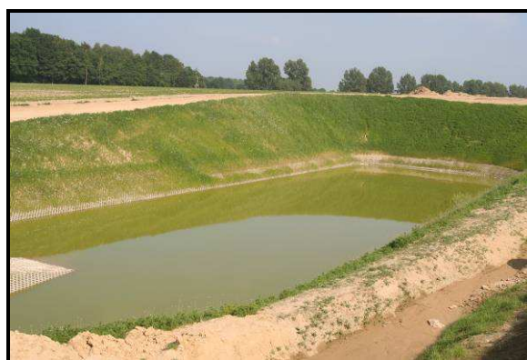
Fot. 11.2 Przykład zbiornika o konstrukcji betonowej z płytami ażurowymi przy drodze ekspresowej S3
