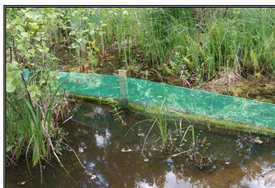
Fot. 11.7 Wygradzenia przed migrującymi płazami na placu budowy drogi ekspresowej S3
