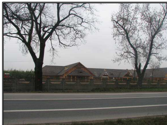
Fot. 4.6 Budynek hotelowo-restauracyjny w sąsiedztwie planowanego węzła „Młodocin” i istniejącej DK Nr 7
