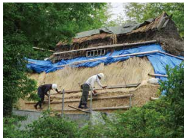
日本民家集落博物館 秋山の民家 修理
