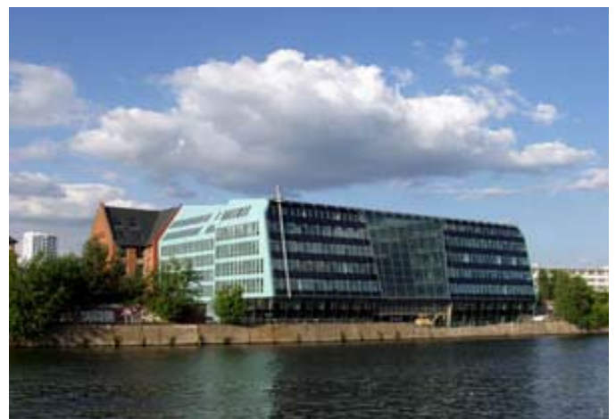
Ansicht von Süd-West
