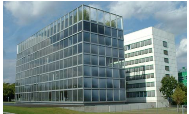
Ansicht von Süd-West
