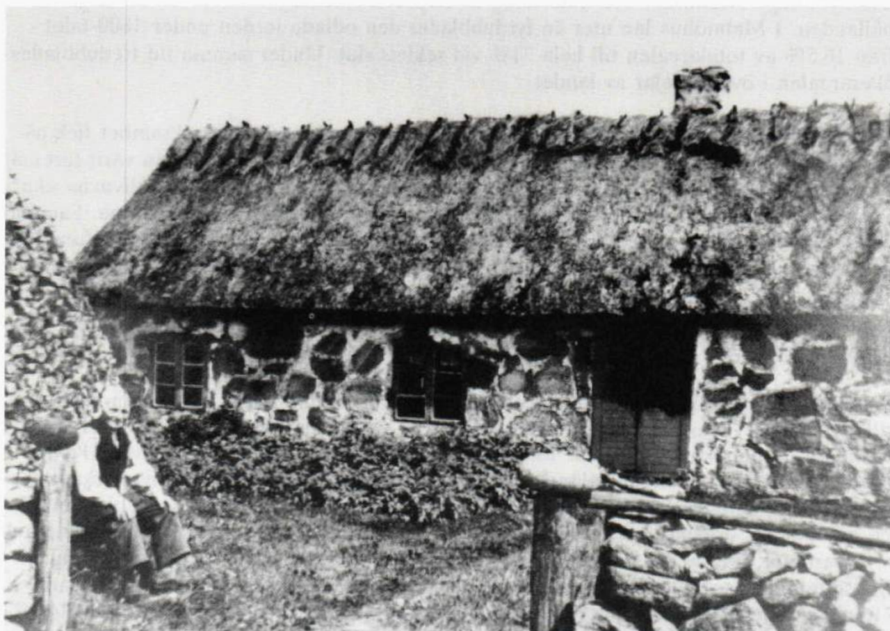
Brinkesholm. Stenhuggaren Jens Beijer framför sin stuga byggd i gråsten under halmtak. Foto: Okänd, början av 1900-talet.
