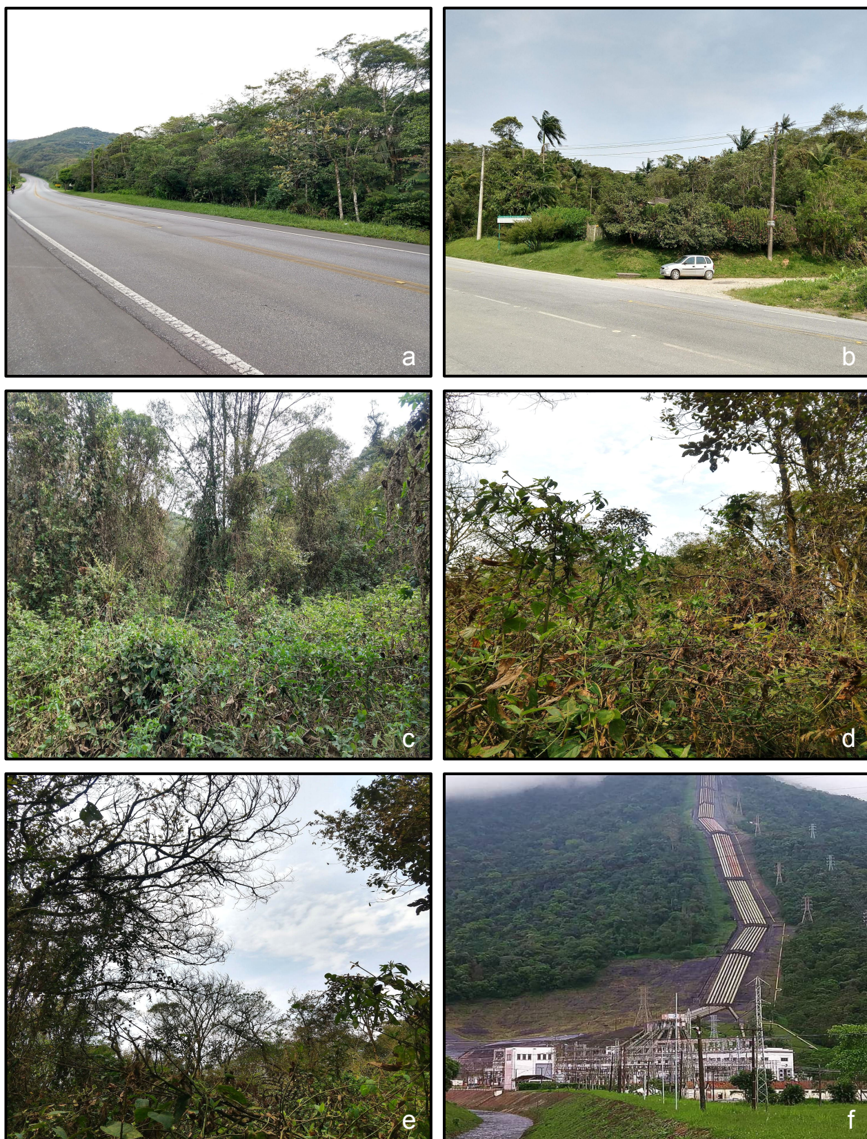
Figura 7 a-f. a. Trecho da Rodovia SP-122 que margeia a entrada da RBASP. b. Cruzamento da SP-122 com rua aberta em terreno da RBASP com área ocupada. c-e. Diferentes trechos da floresta com visível perturbação ambiental, com dossel escasso, árvores mortas e presença de trepadeiras oportunistas encobrendo o solo e sufocando a vegetação (Fotos: Oliveira, DS. 2020). f. Vista do Pólo petroquímico de Cubatão com gasodutos subindo as encostas da Mata Atlântica na Serra do Mar (Foto: Diário do Turismo, 2020).
