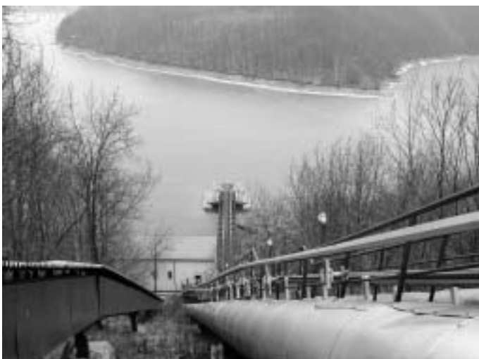
Obr. 5: Čerpací stanice na pontonu, nádrž Vranov nad Dyjí
