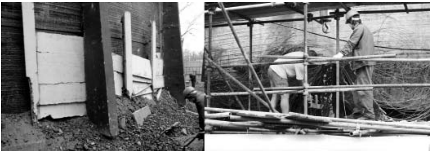
Obr. 2: Odstraňování prvků opláštění a zcela uvolněné dráty původního ovinutí
