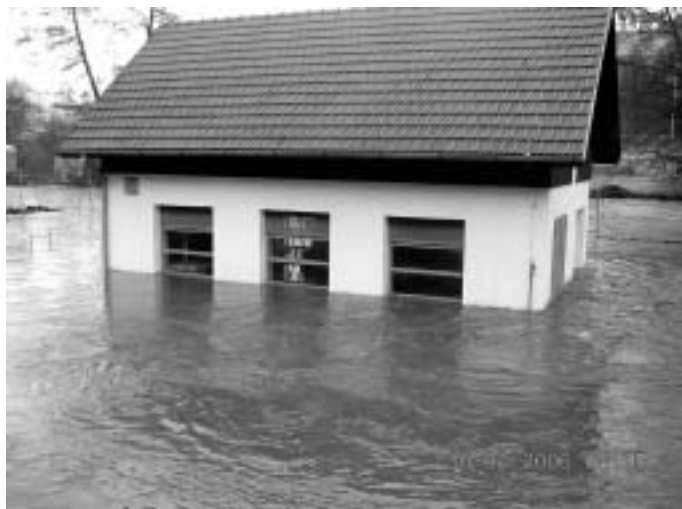
Obr. 3: Zaplavená ČOV Bílovice nad Sv., okr. Brno-venkov
