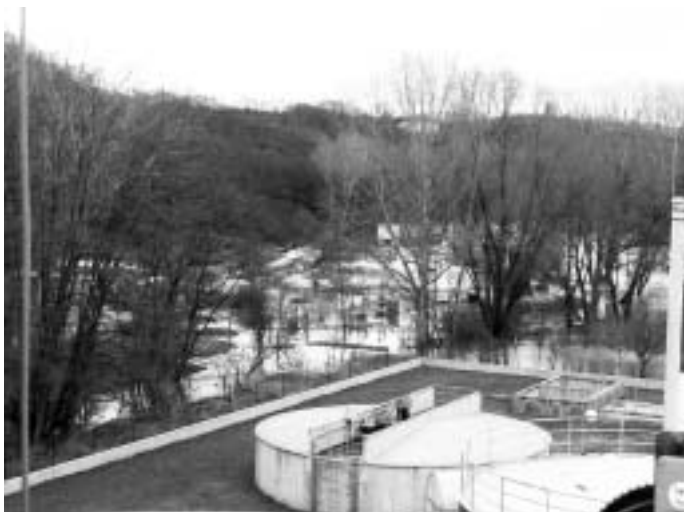
Obr. 1: ČOV Znojmo za protipovodňovou hrází
