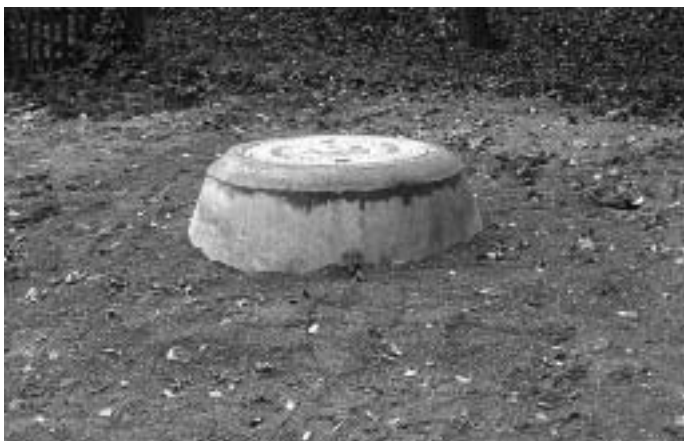
Obr. 4: Kanalizační šachta v zahradě
