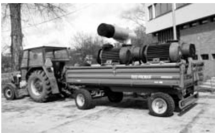
Obr. 2: Demontáž zařízení na ČOV Znojmo
