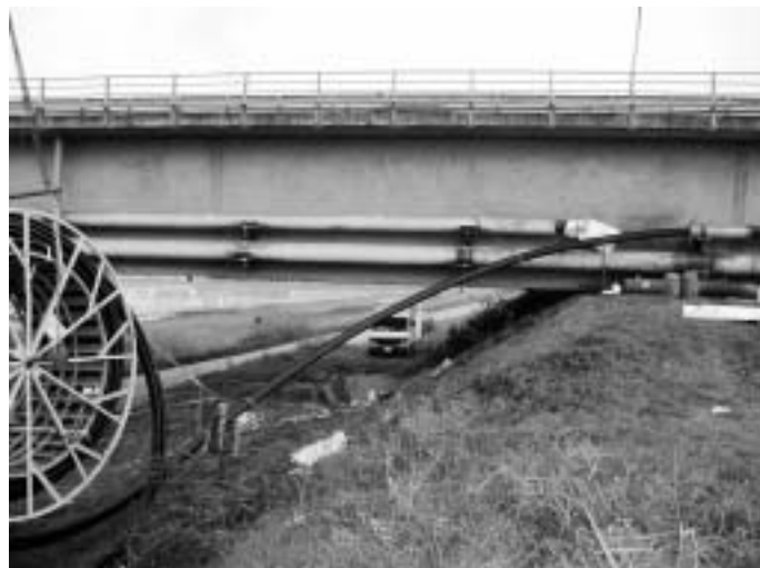
Zatahování polotovaru do sanované trubky
