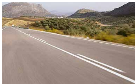
Calzada en buen estado.
