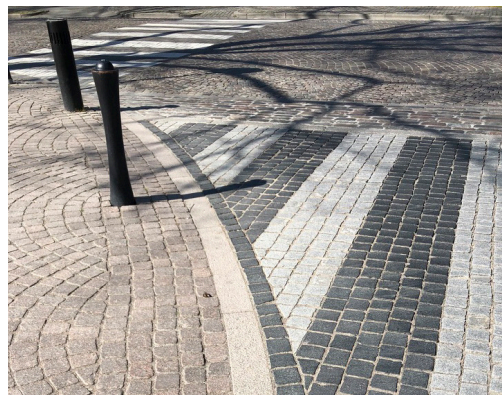
Bild 2. 0-nivå mellan gata och trottoar. Pollare kontrasterar och marlerar gränsen mellan torg och gata.
