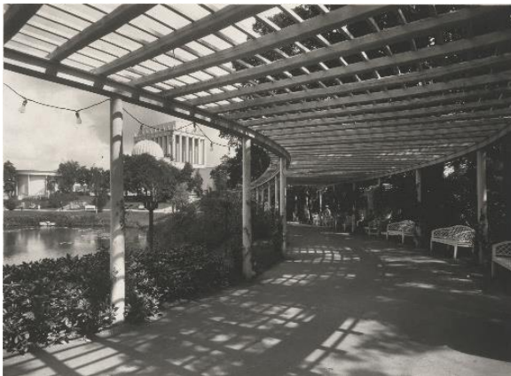
Figur 14: Pergolan vid dammen (ArkDes 1923).
