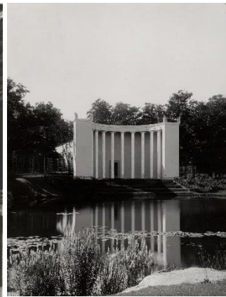
Figur 15: Dammen och Idrottshallen (Tekniska museet 1923).
