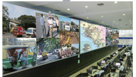
台達提供 LED 光源之 DLP 大型屏幕監控系統於印度 Bangalore 的第一座行控中心
