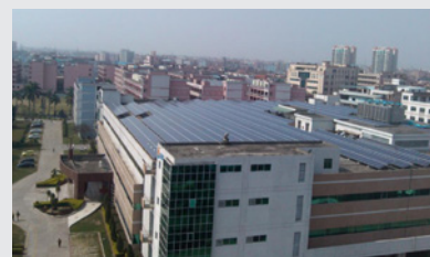
東莞廠區金太陽工程 -2.117MWp
