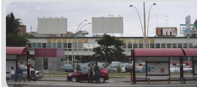
3 . Stazione autolinee: vista del prospetto principale da piazza XX settembre.
