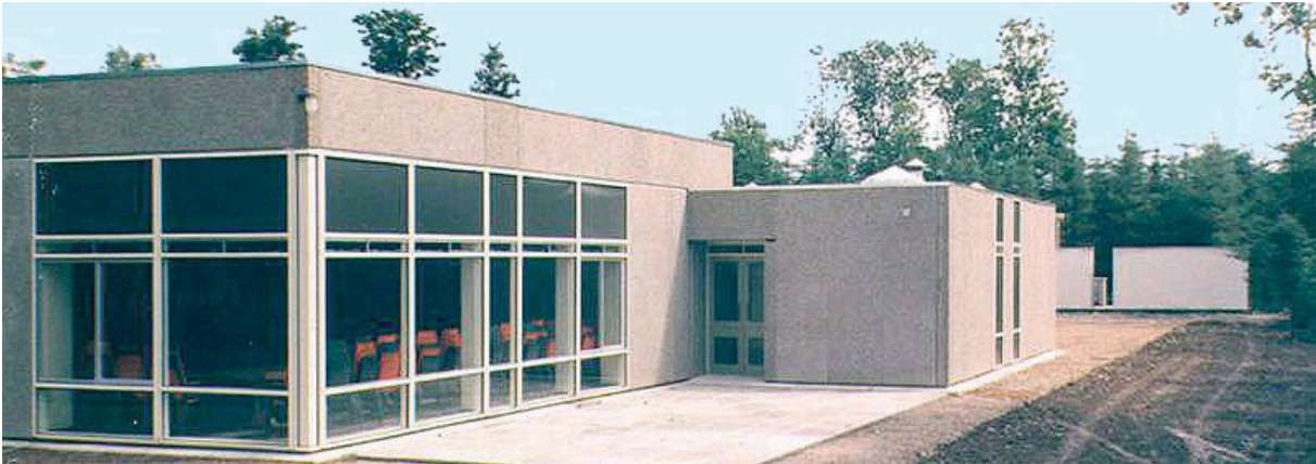
Figura 434 - Fotografia de escola pública pré-fabricada com sistema CLASP, em 1974, em Londres. Fonte: CLASP, 1974
