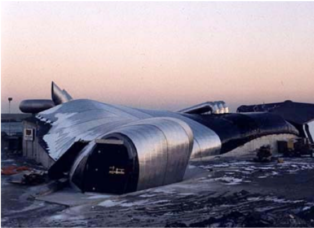
Fig. 2 – Pavilhão da água: construído por ocasião da expo fresh20 eXPO
