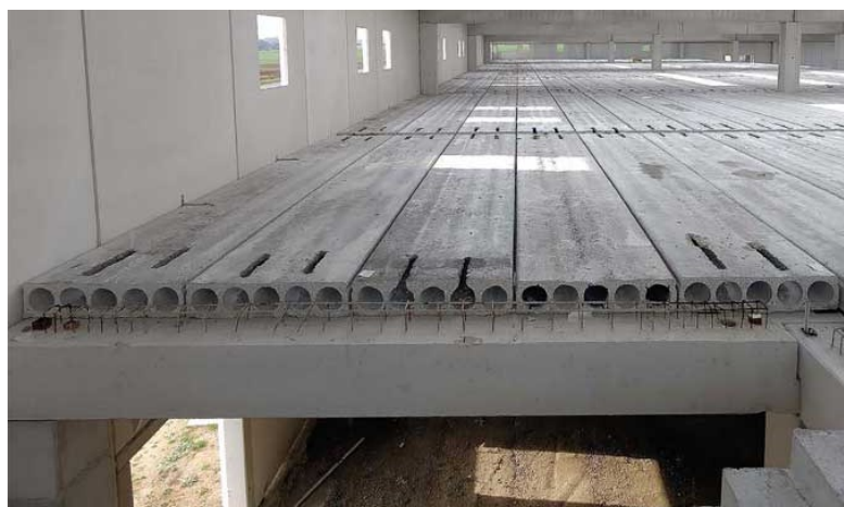
Figura 13: Solaio alveolare.
