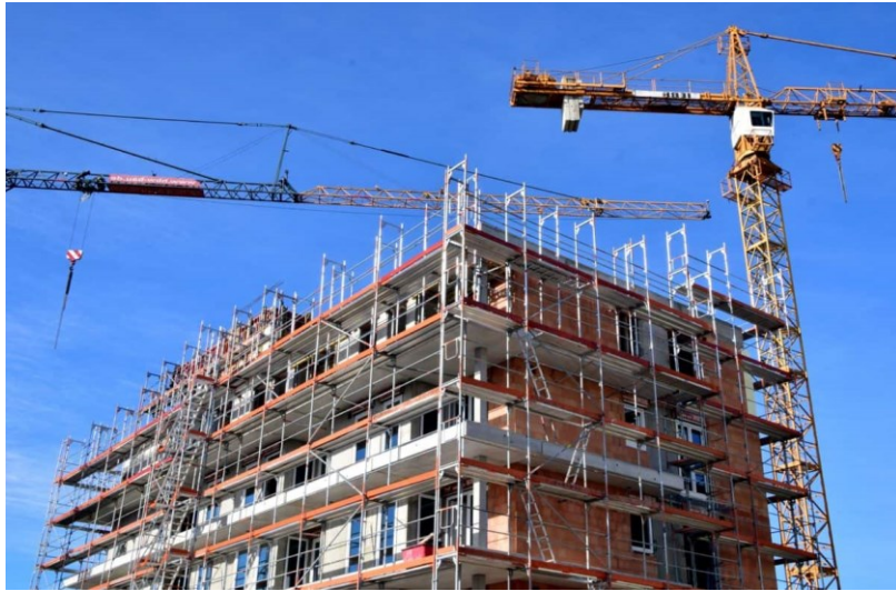
Figura 1: Fase realizzativa di un edificio per civile abitazione.
