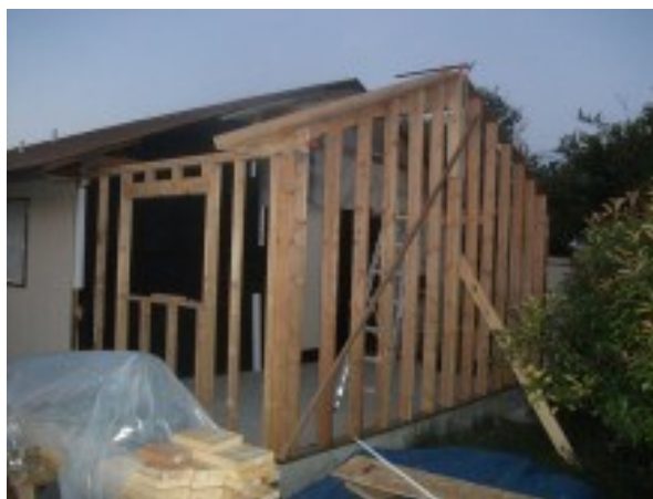
Figura 21: Prefabbricazione leggera in legno a telaio tradizionale: Balloon Frame.
