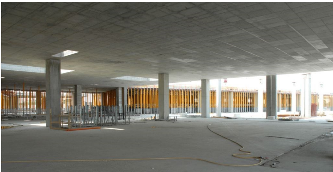
Figura 62: Centro commerciale Auchan a Cinisello Balsamo; vista interna della maglia dei pilastri dopo il disarmo dell'impalcato.
