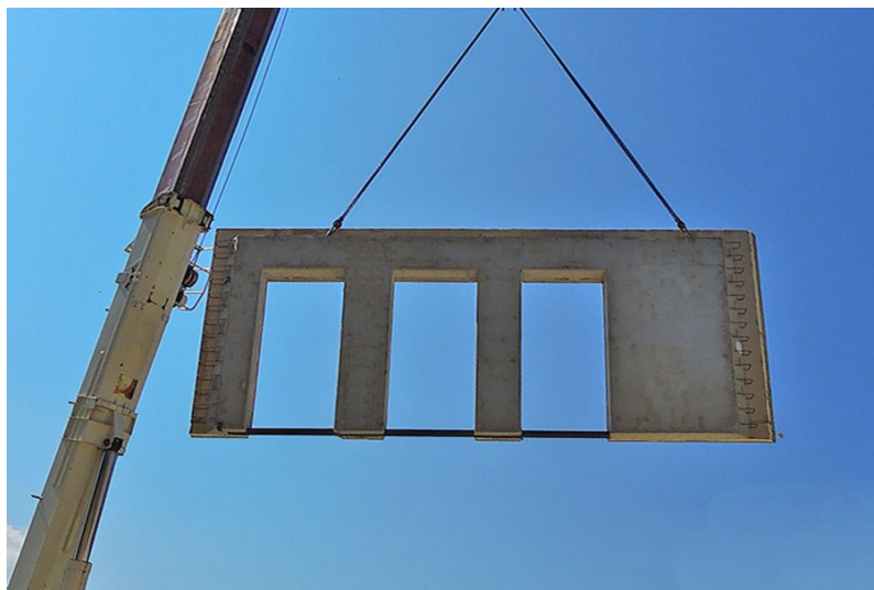
Figura 14: Prefabbricazione pesante a grandi pannelli: sollevamento in cantiere di un pannello-parete prefabbricato.
