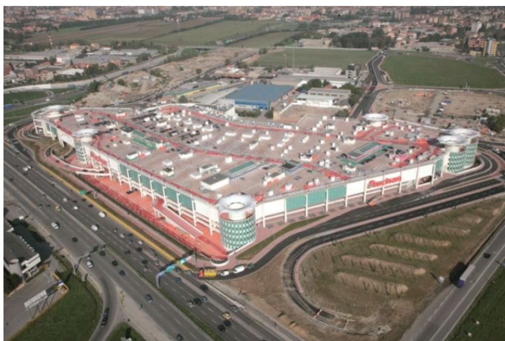
Figura 58: Centro commerciale Auchan a Cinisello Balsamo; vista complessiva del fabbricato.
