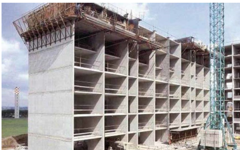
Figura 46: Strutture realizzate con la tecnica del "Coffrage tunnel".
