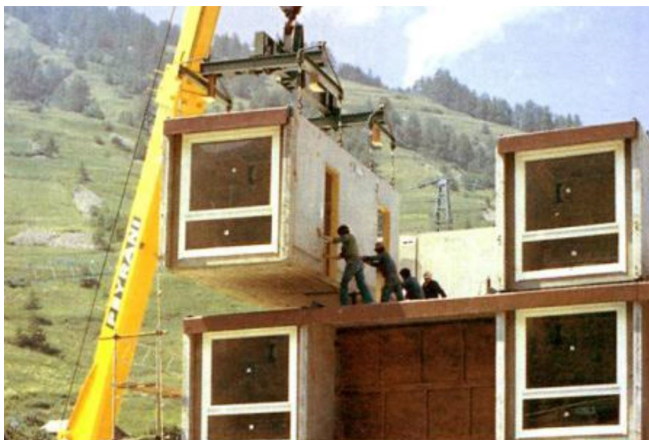
Figura 17: Prefabbricazione pesante a cellule spaziali: sollevamento e posizionamento dei moduli abitativi.
