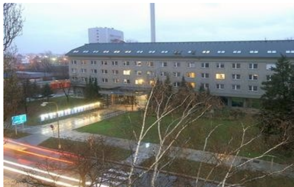
Obr.2 Sídlo Úřadu práce v Olomouci
