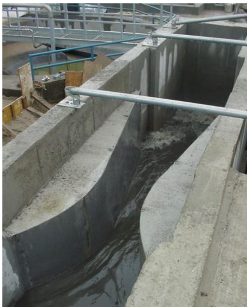
Obrázek 1.8: Venturiho žlab (papay.sk, 2022)
