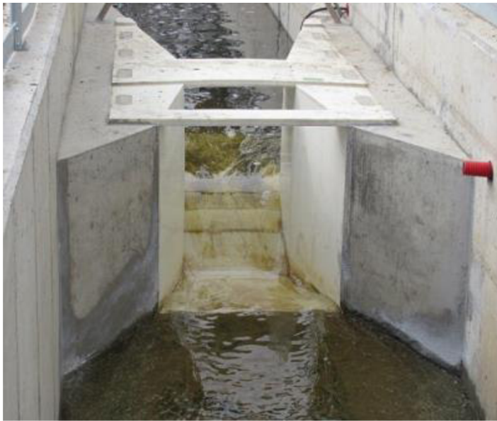
Obrázek 1.6: Pohled na Parshallův žlab (cdn.bitrix24.eu, 2022)
