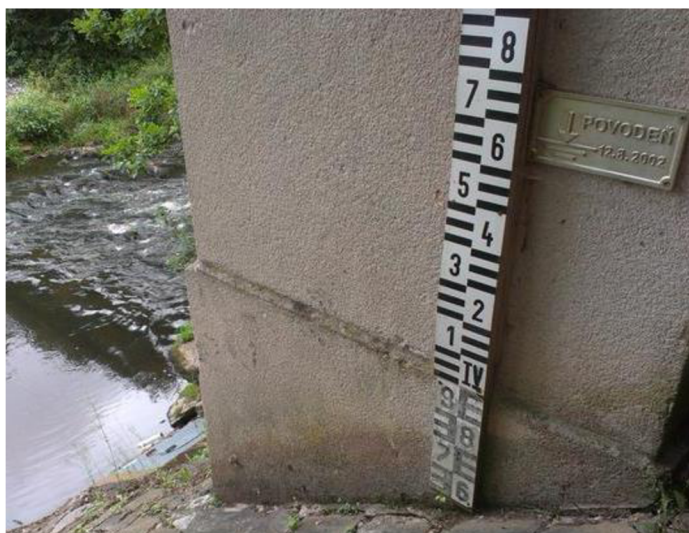
Obrázek 1.13: Vodočetná lať (d34-a.sdn.cz, 2022)
