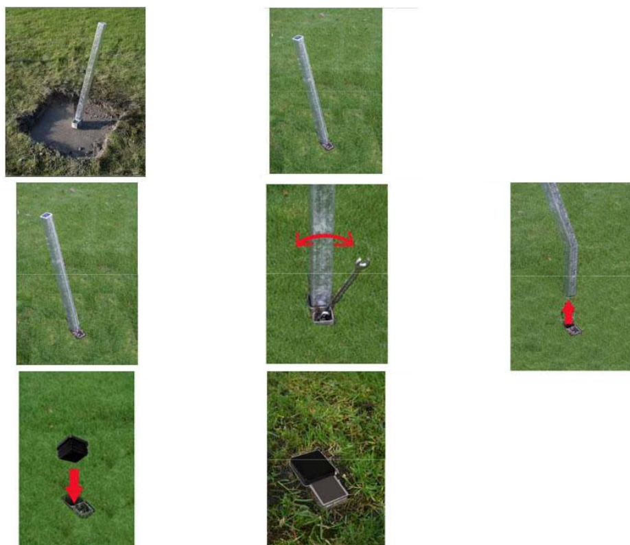
Obr. 35: Ingenua - Příprava základu
