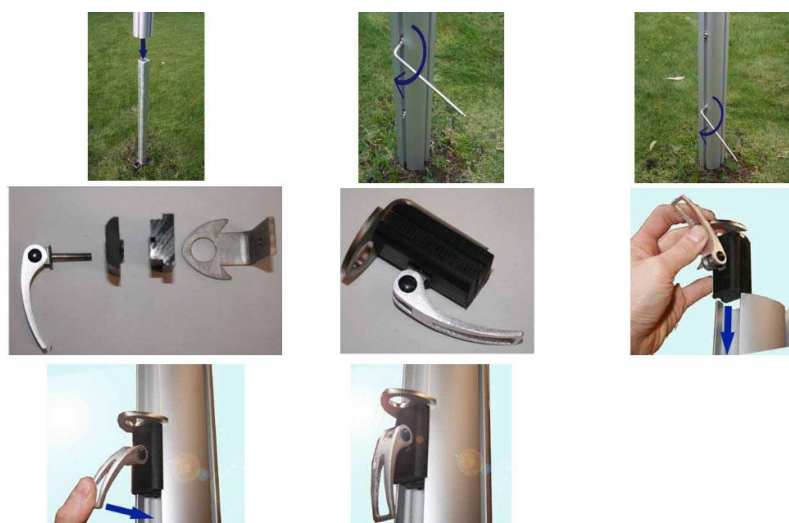
Obr. 33: Ingenua - Instalace sloupku
