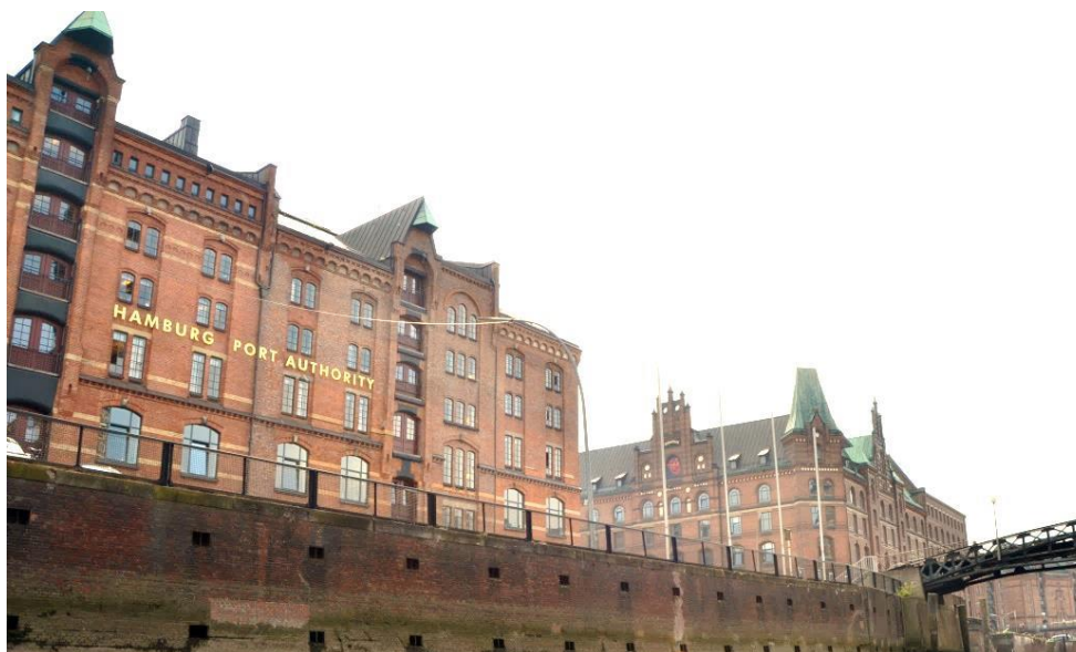
Figure 10 – Bâtiment de l'autorité portuaire d'Hambourg
