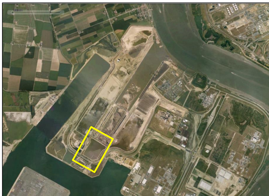
Figure 84 – Photographie aérienne de 2004 : début du remblaiement de la partie nord-ouest du Doeldok (à l'ouest) avec les déchets de dragage et début de l'ouverture du Containertijdok (au centre-nord).
