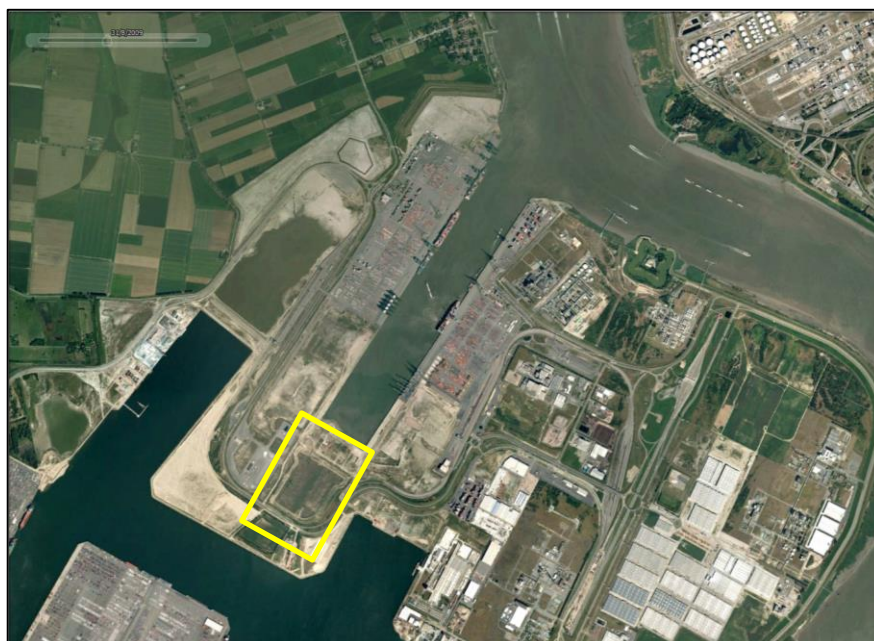
Figure 86 – Photographie aérienne de 2009 : poursuite des travaux
