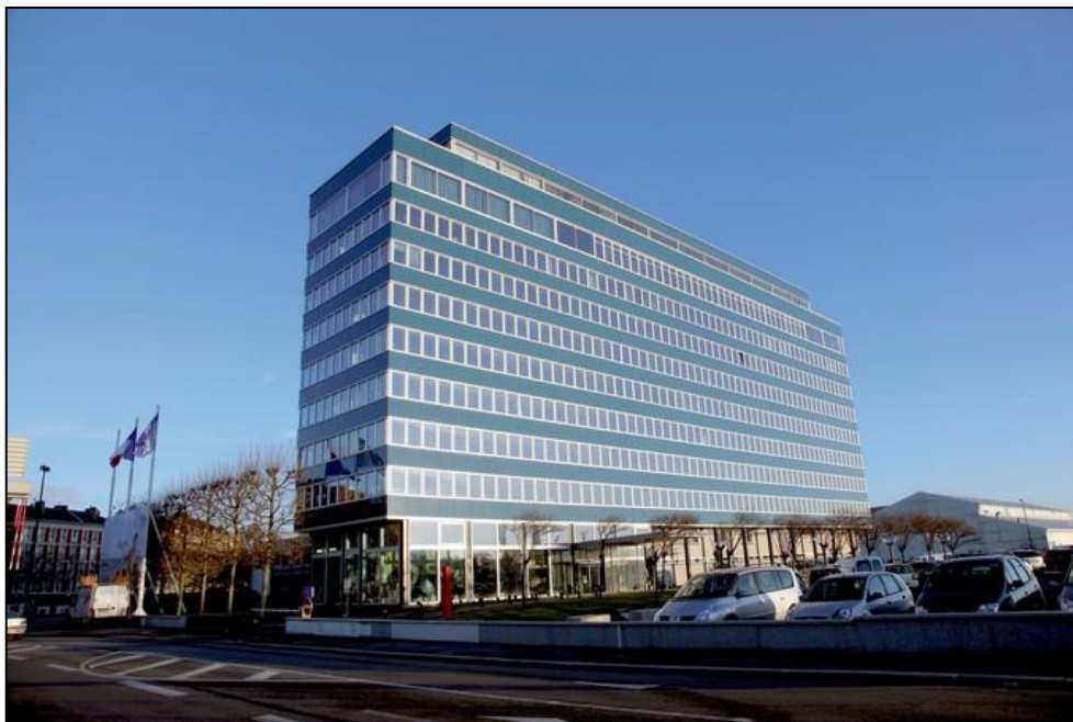
Figure 96 – Bâtiment de l'autorité portuaire havraise
