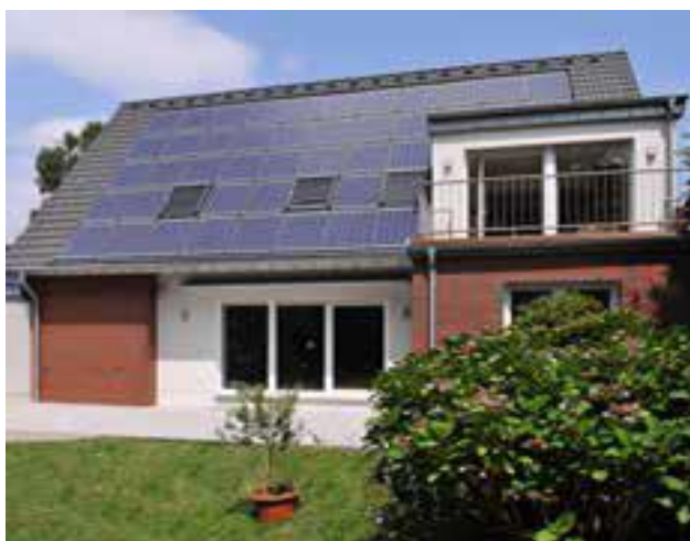
Figura 31; foto della casa riqualificata all'interno del programma "ZUKUNFTSHÄUSER+". Fonte: InnovationCity Ruhr – Model City Bottrop: revitalizing an industrial region through low-carbon redevelopment and active public-private partnerships
