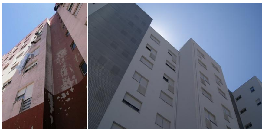
Figura 37, fotografie degli edifici prima e dopo la riqualificazione energetica.
