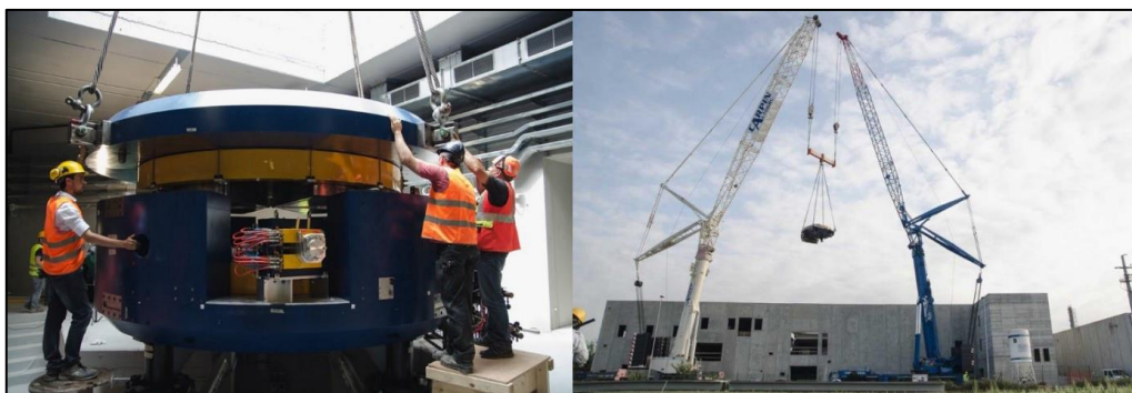
Fig. 1.6 Fasi di installazione del ciclotrone nell'edificio SPES. Maggio 2015.
