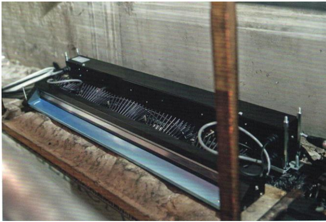
Figura 4.6 – Montaggio del proiettore V400 lungo la cornice marcapiano; a destra, la curva fotometrica dell'apparecchio.
