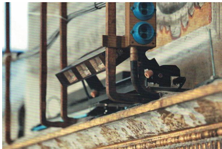
Figura 4.10 – Montaggio del proiettore per l'illuminazione del piano di calpestio.
