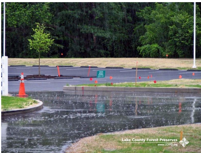
Immagine 9 - Confronto tra asfalto drenante (sullo sfondo) e tradizionale (in primo piano)
