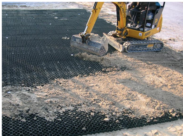
Immagine 8 - Riempimento con substrato di grigliato plastico MODI' Garden Grid
