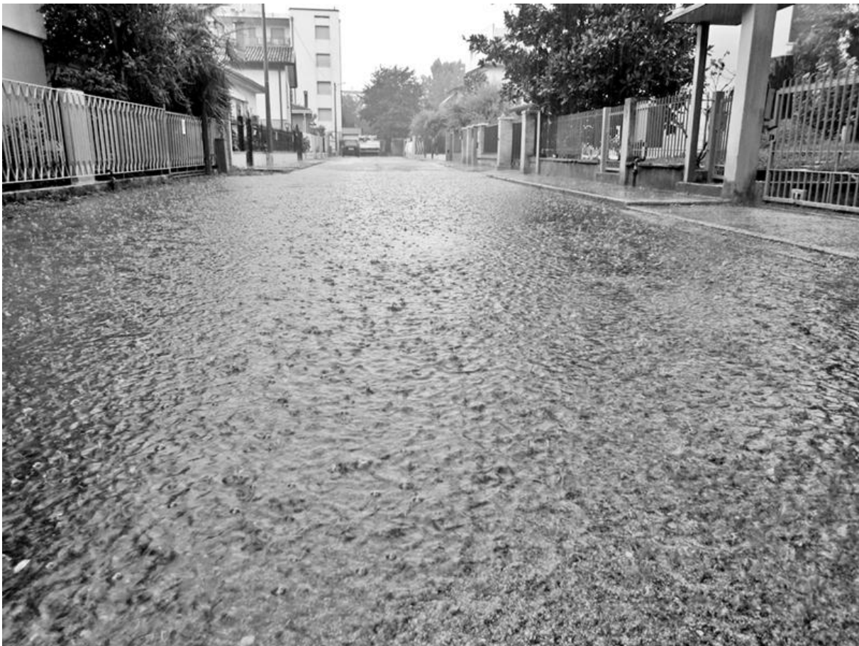
Immagine 1 - L'effetto di precipitazioni intense su un'area urbana come la rete di fognatura velocemente saturata (settembre 2012)
