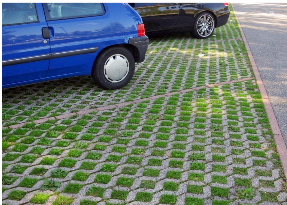
Immagine 5 - PP in grigliato in calcestruzzo inerbato. L'ombra degli alberi nelle ore centrali della giornata permette la sopravvivenza del cotico anche d'estate.
