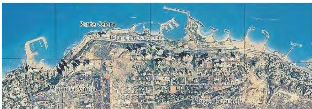
Figura 1. Espigones en serie del Litoral Central, Estado Vargas, Venezuela. Sector entre Cabo Blanco (foto superior) y Catia la Mar (foto inferior). Imágenes de Google Earth.
