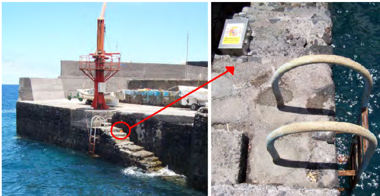
Figura 3. Mareógrafo instalado en un dique
