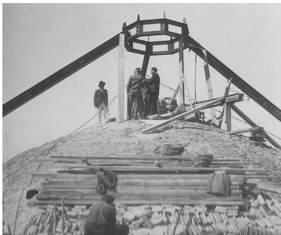
Fig. 12.A. Hospital de Tavera sin la linterna; B. Arreglo de la linterna después de la Guerra Civil.
