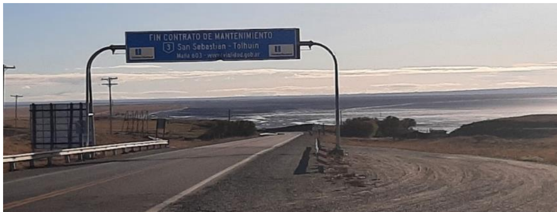
Ruta Nacional N°3. Fin de concesión de mantenimiento
