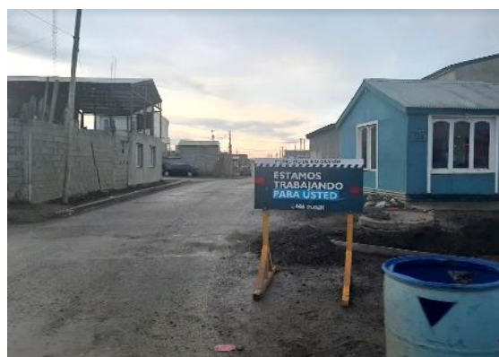
Margen Sur. Obras municipales
