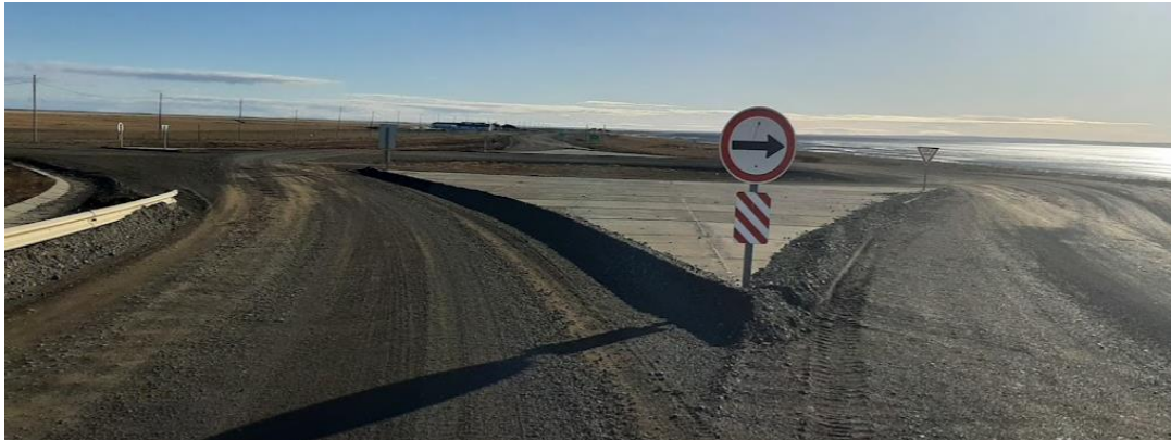
Ruta Nacional N°3. Inicio tramo sin asfalto (San Sebastián)
