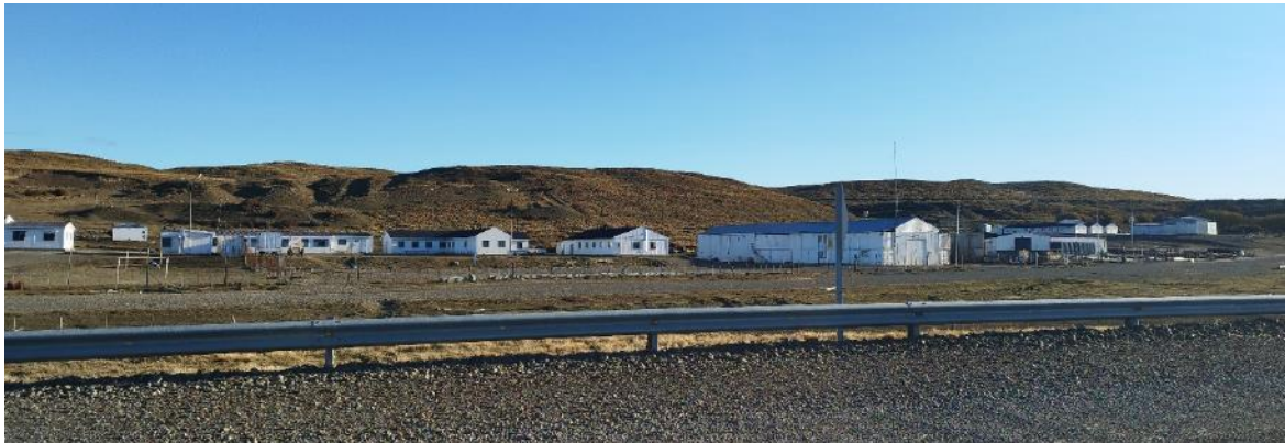
Vista del Campamento desde la ruta 3.
