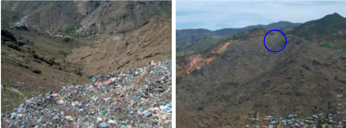
Şekil 9. Gümüşhane katı atık depolama alanı yüzeysel su biriktirme sisteminin depolama alanından ve karşıdan görüşleri Figure 9. Dump site and opposite views of superficial water accumulation system in the Gümüşhane solid waste dump site
