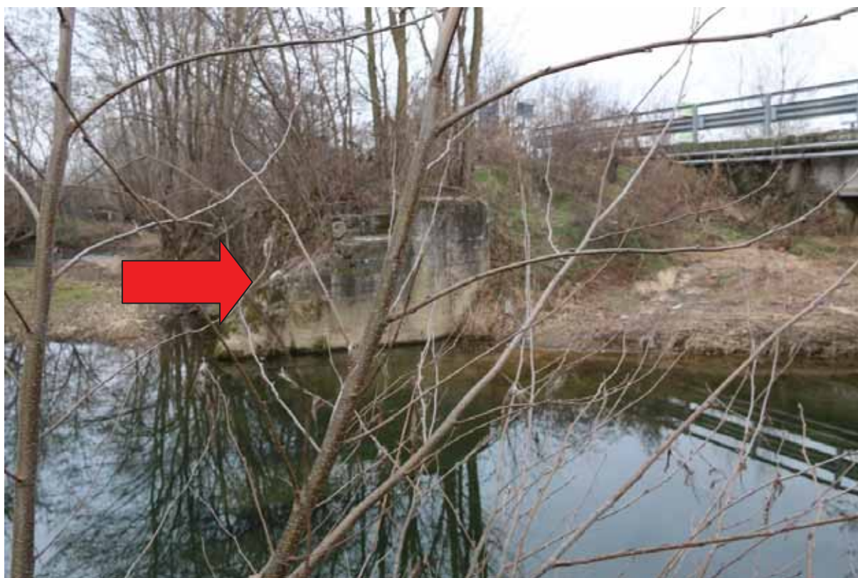
individuazione del muro da demolire
