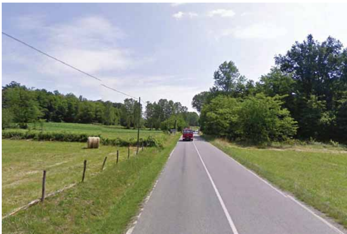
Foto della SP23 lungo il tratto interessato - Google Maps
