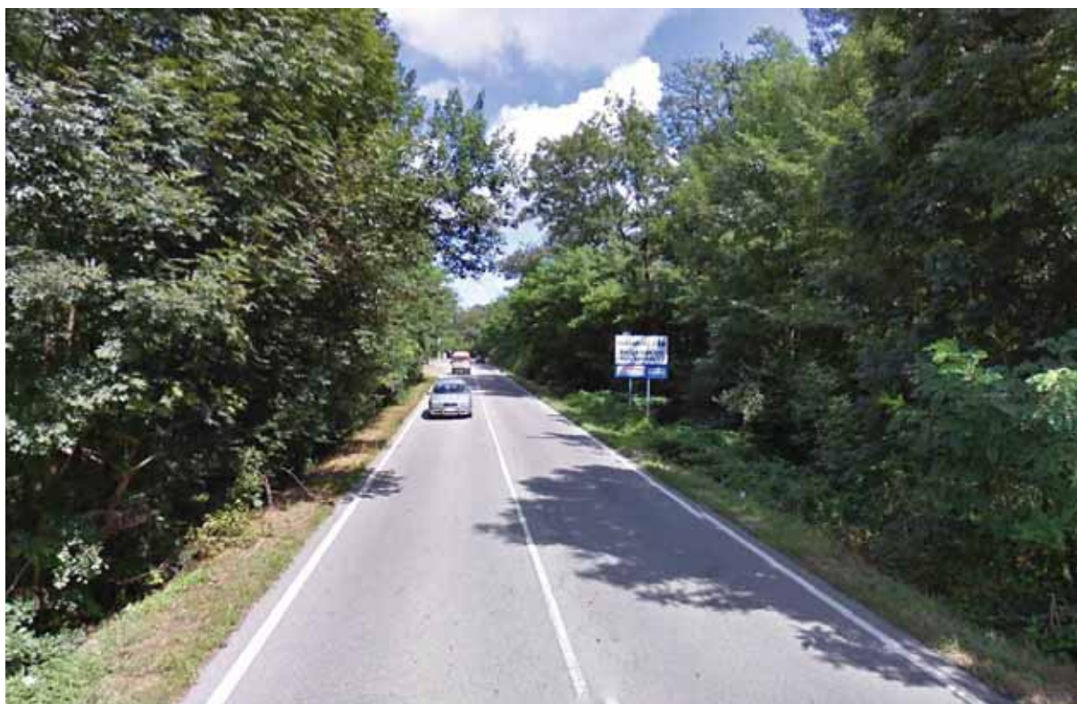
foto della SP 33/A nel tratto interessato - Google Maps
