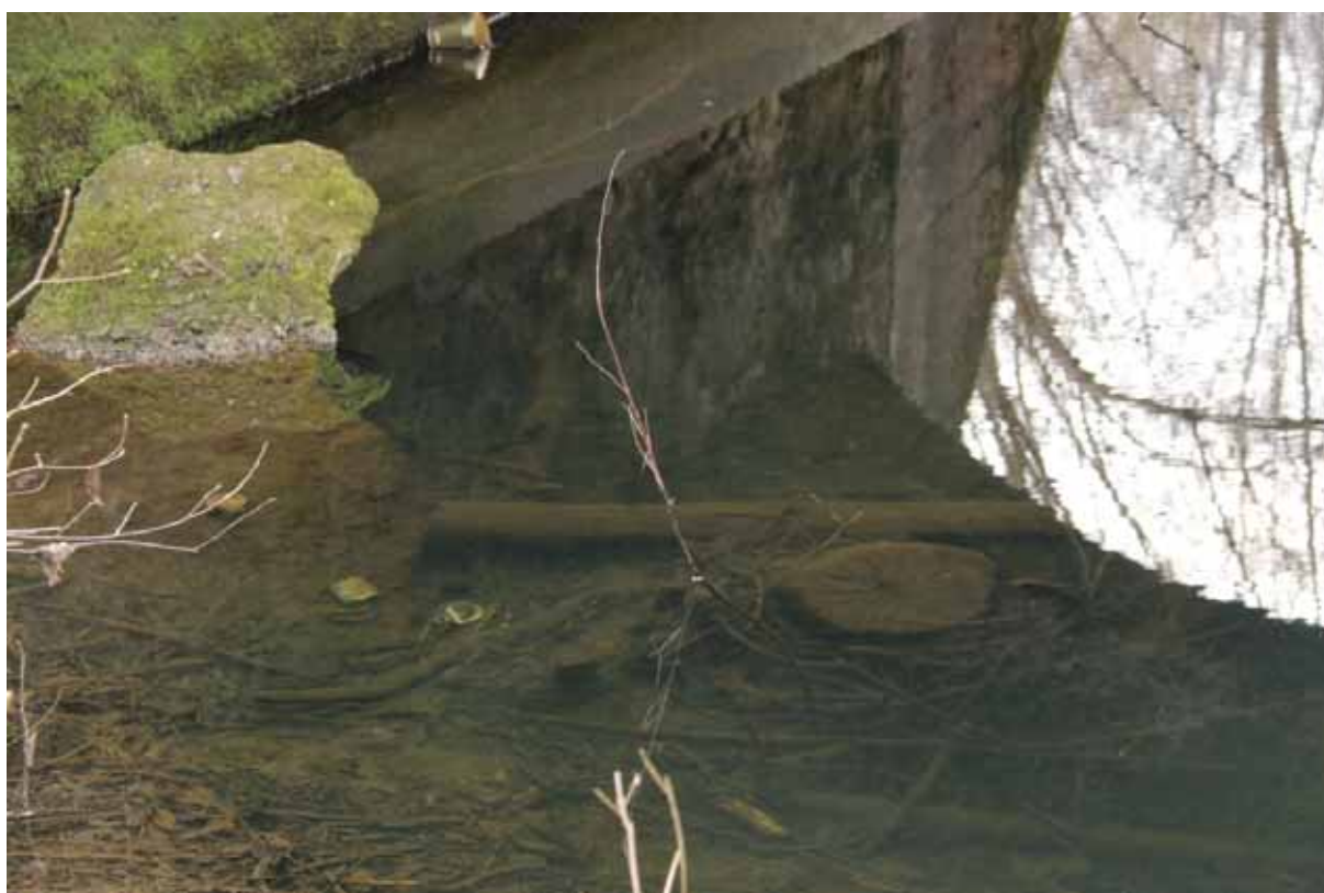
foto del fondo esistente del Torrente Lirone sotto la SP84
