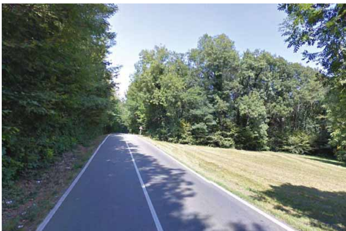
foto della SP-34 lungo il tratto interessato - Google Maps
