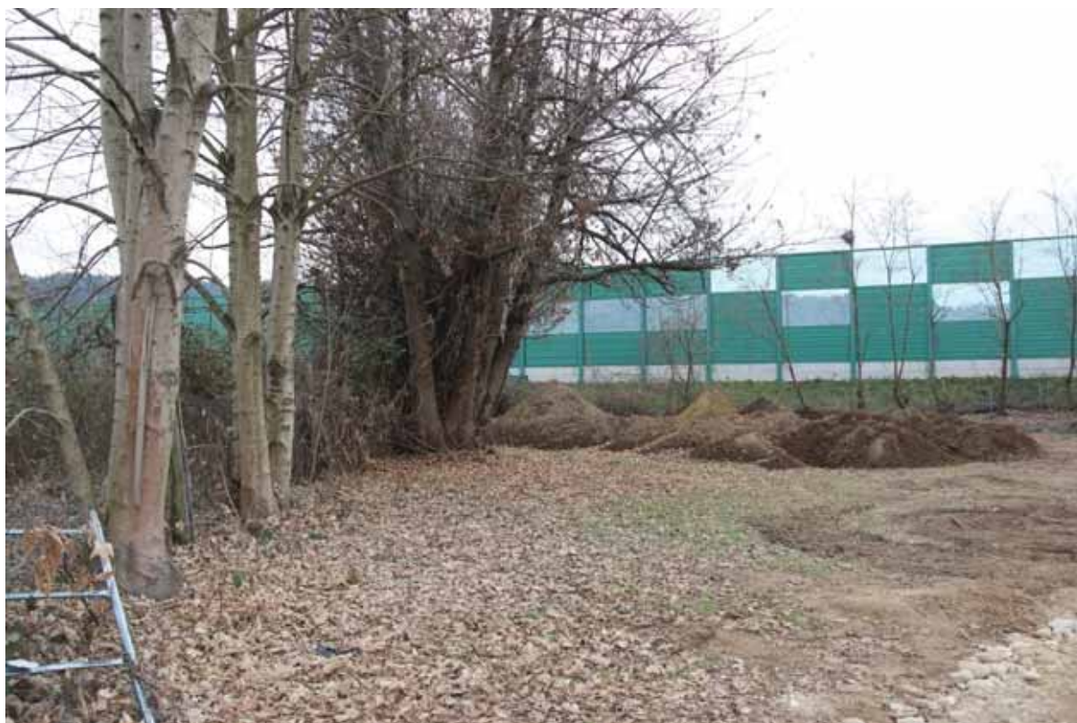
foto della recinzione da rimuovere o adeguare
