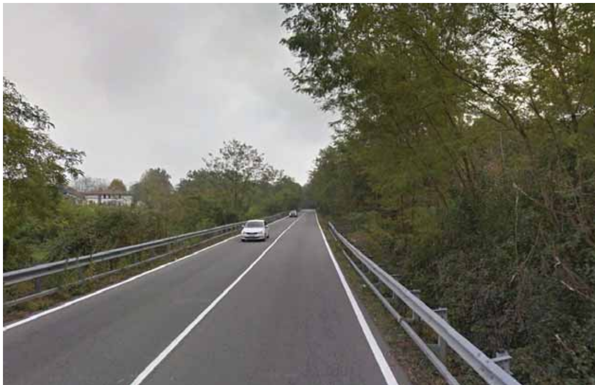
foto della SP32 lungo il tratto interessato - Google Maps
