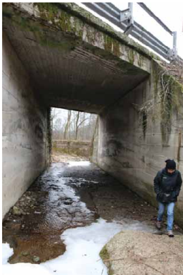
foto del sottopasso del Torrente Terzago sulla SP34
