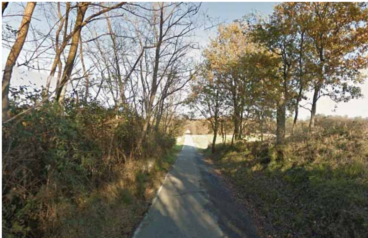
foto della SP105 lungo il tratto interessato - Google Maps
