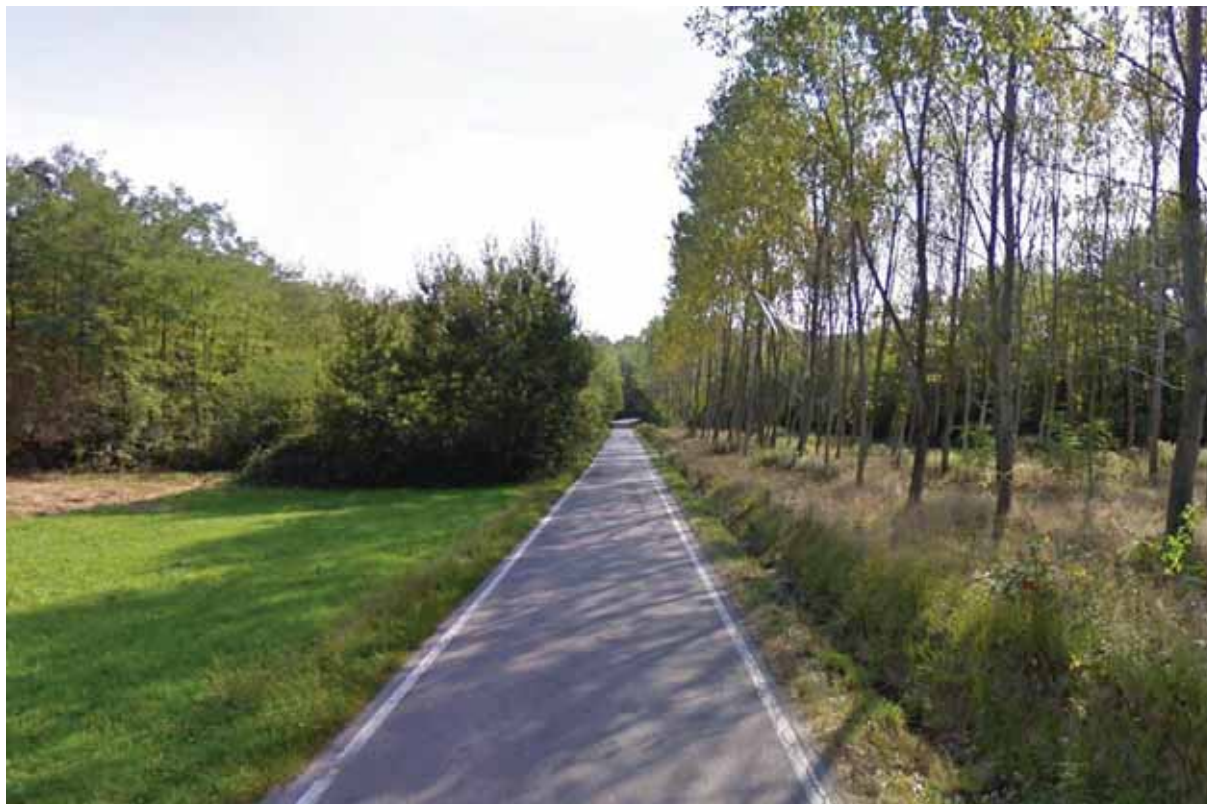
Foto della SP18 lungo il tratto interessato - Google Maps
