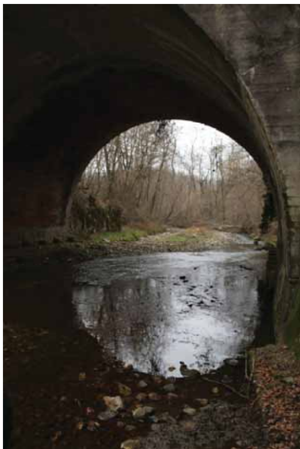
foto del sottopasso del Torrente Vevera
