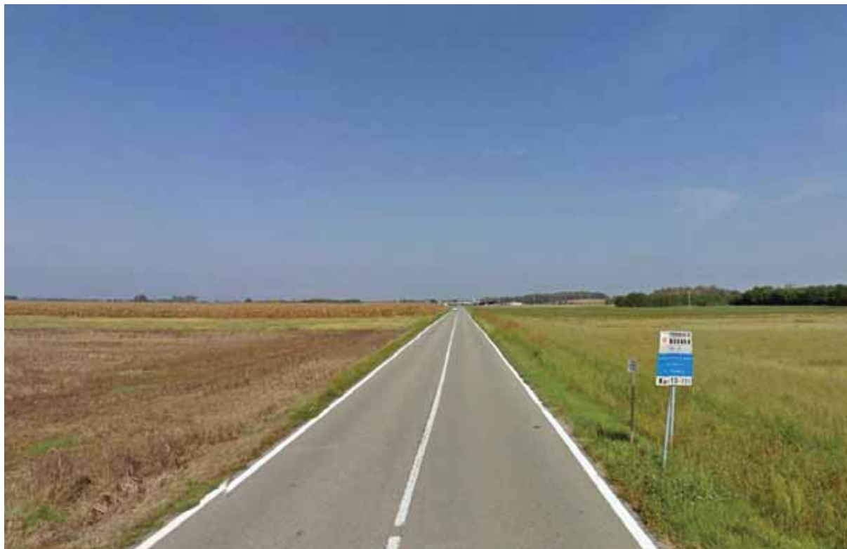
foto della SP19 lungo il tratto interessato - Google Maps
