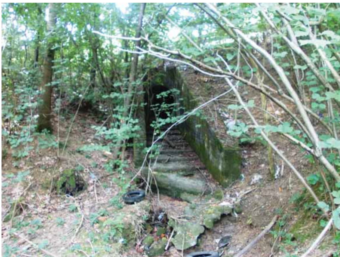
Foto del sottopassaggio esistente sotto la SS142
