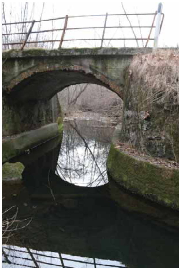
foto del sottopasso esistente del Torrente Lirone sotto la SP84
