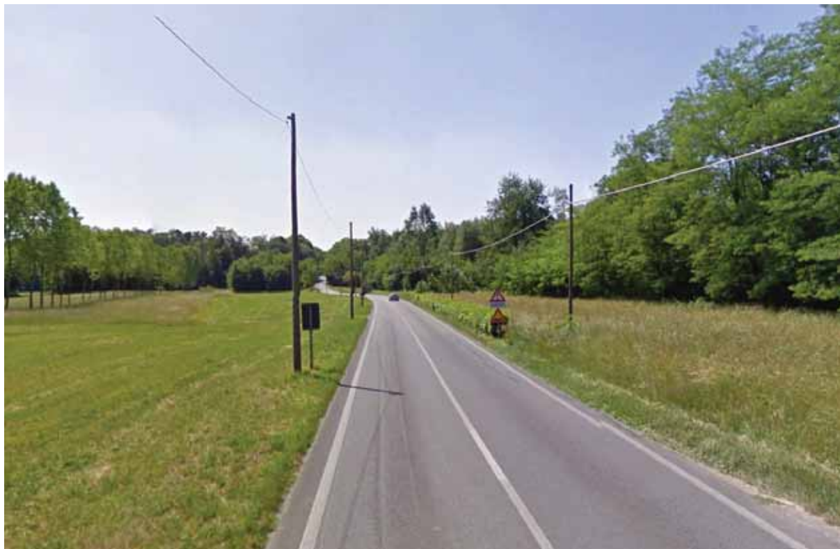
foto della SP29 lungo il tratto interessato - Google Maps
