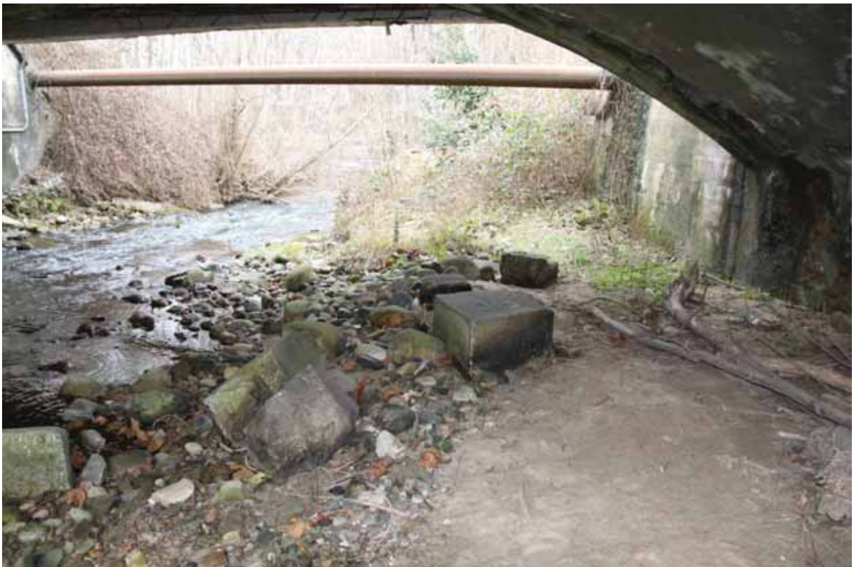
foto del sottopasso oggetto di intervento
