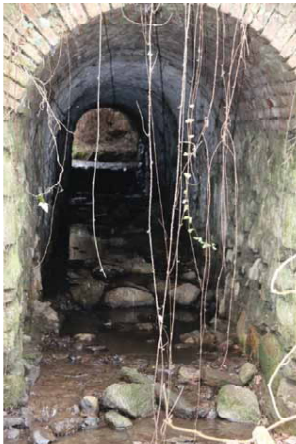
foto di un secondo passaggio sotto la strada comunale
