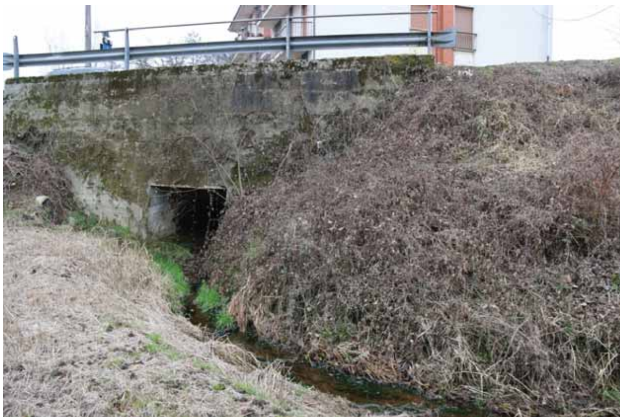
piccolo sottopasso esistente sotto la strada comunale
