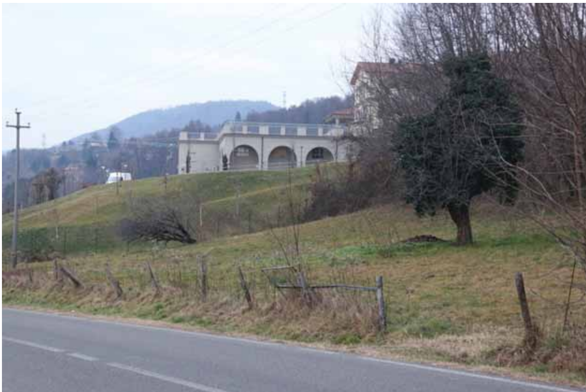
foto della recinzione da rimuovere
