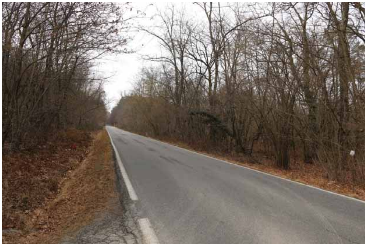
foto della SP84 nel tratto interessato
