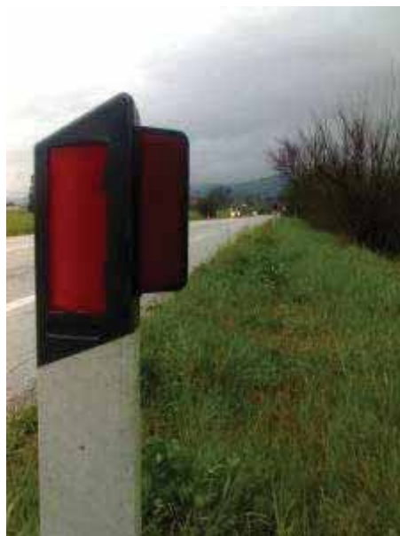
Figura 1.23 - Dissuasore riflettente per la fauna selvatica montato su paracarro lungo una strada provinciale.
