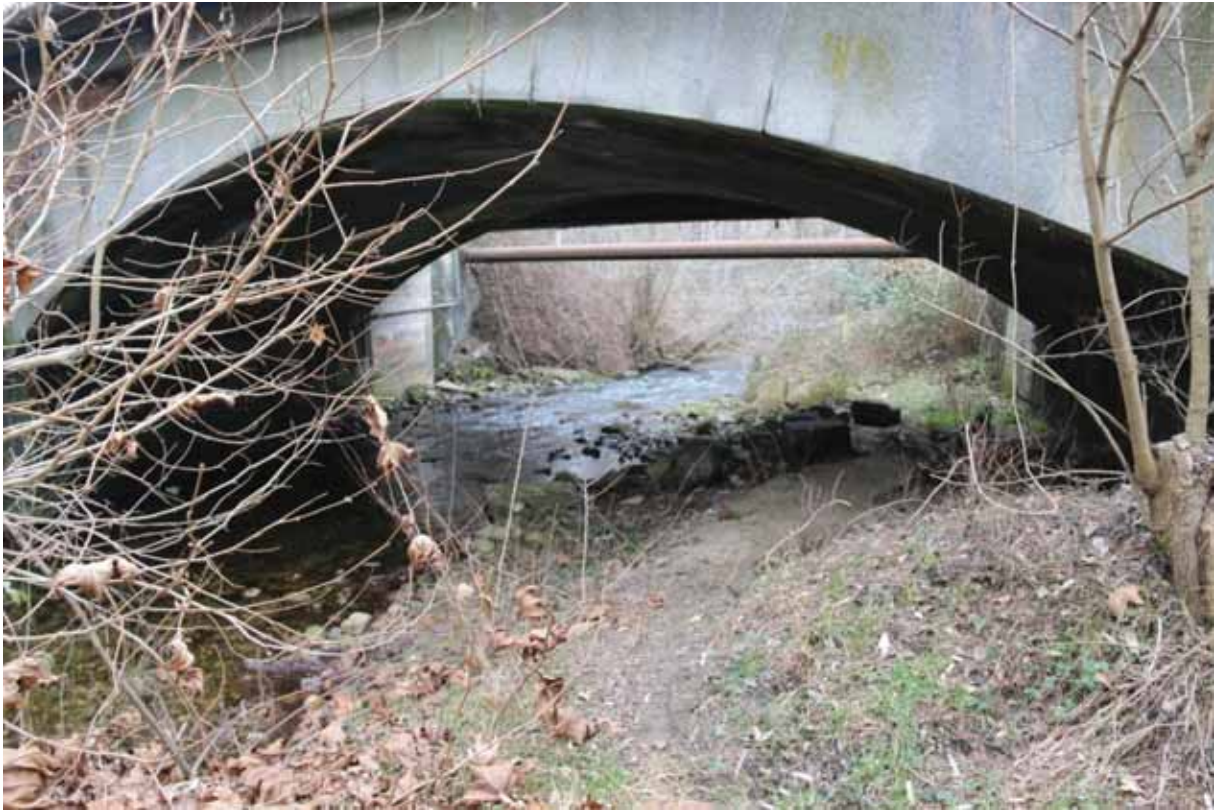
foto del sottopasso oggetto di intervento
