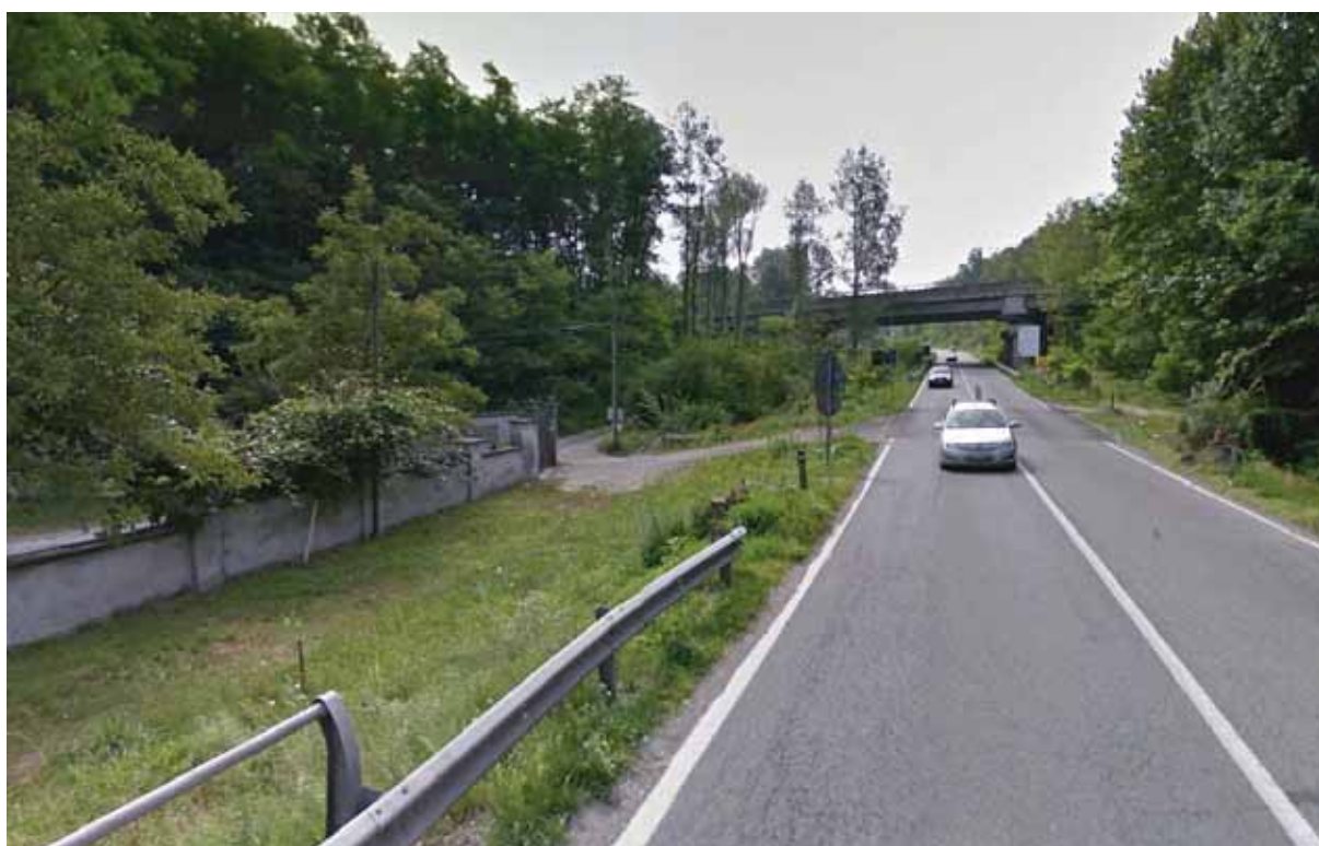
foto del tratto interessato - Google Maps
