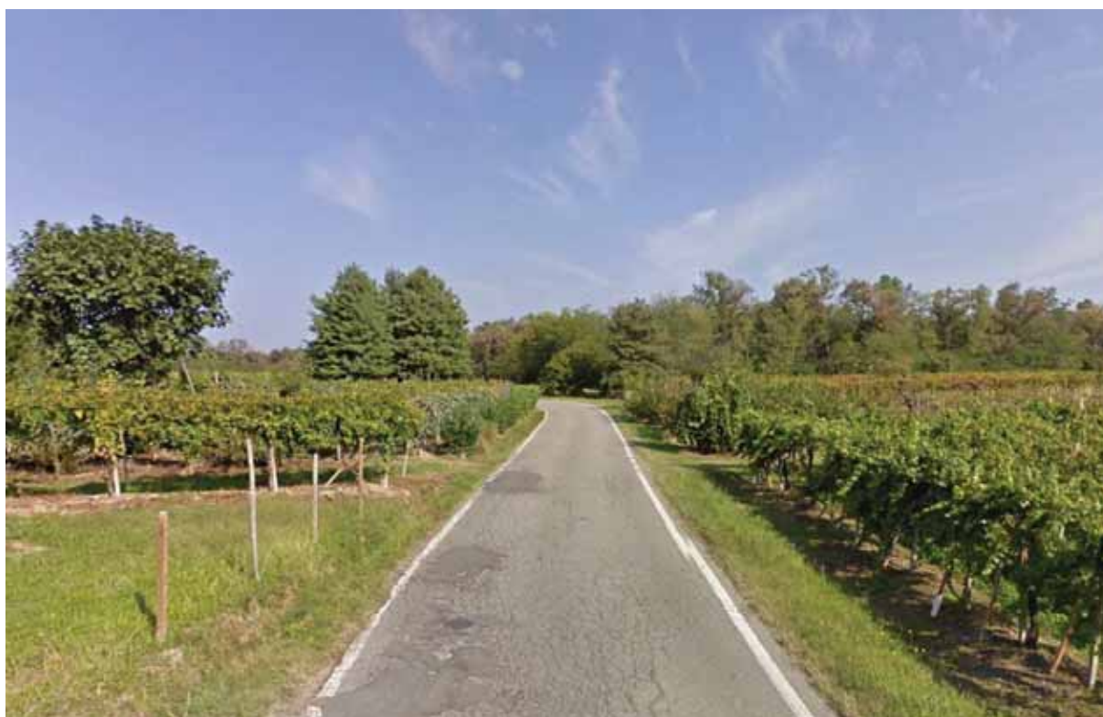
Foto della SP18 lungo il tratto interessato - Google Maps
