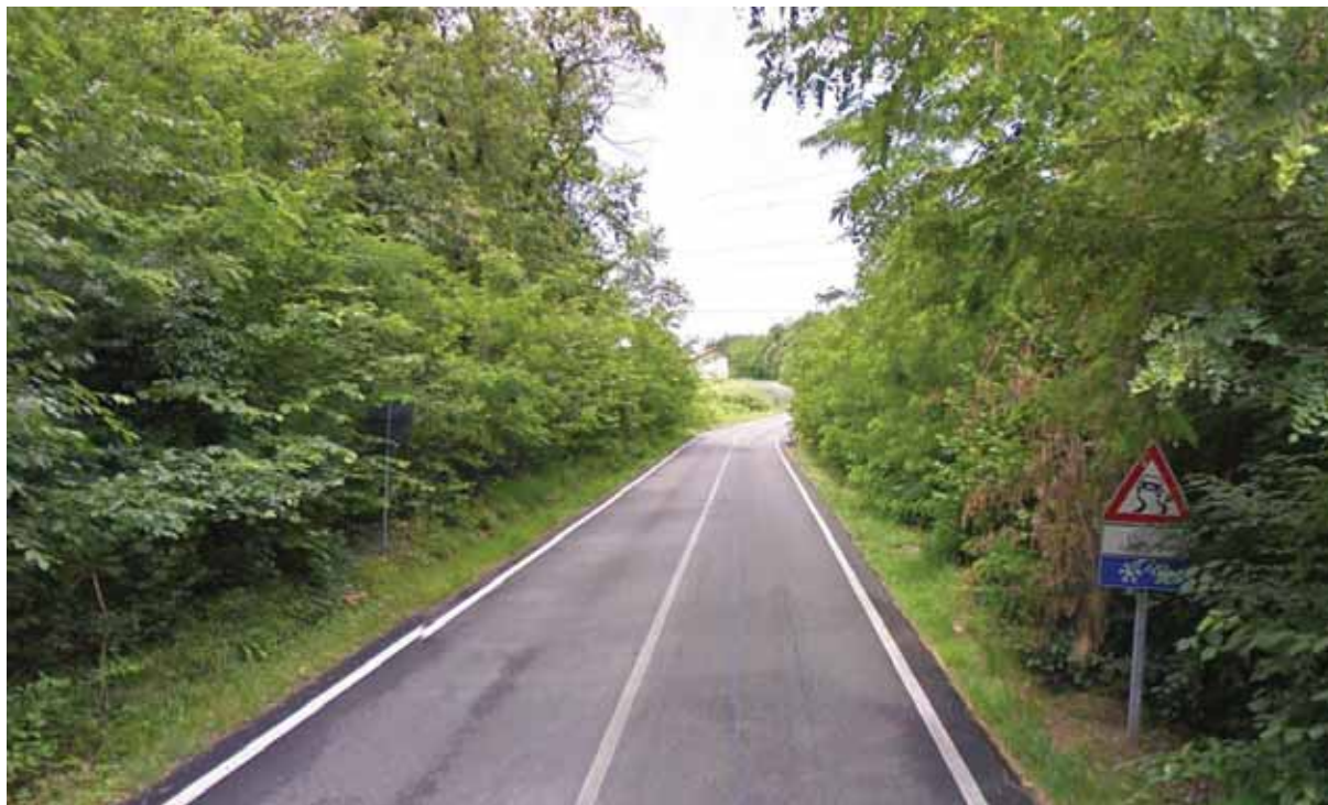
foto della SP166 lungo il tratto interessato - Google Maps
