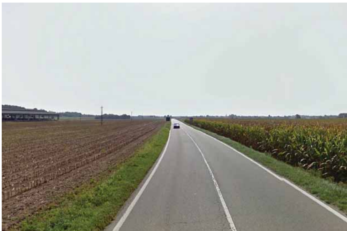
foto della SP19 lungo il tratto interessato - Google Maps
