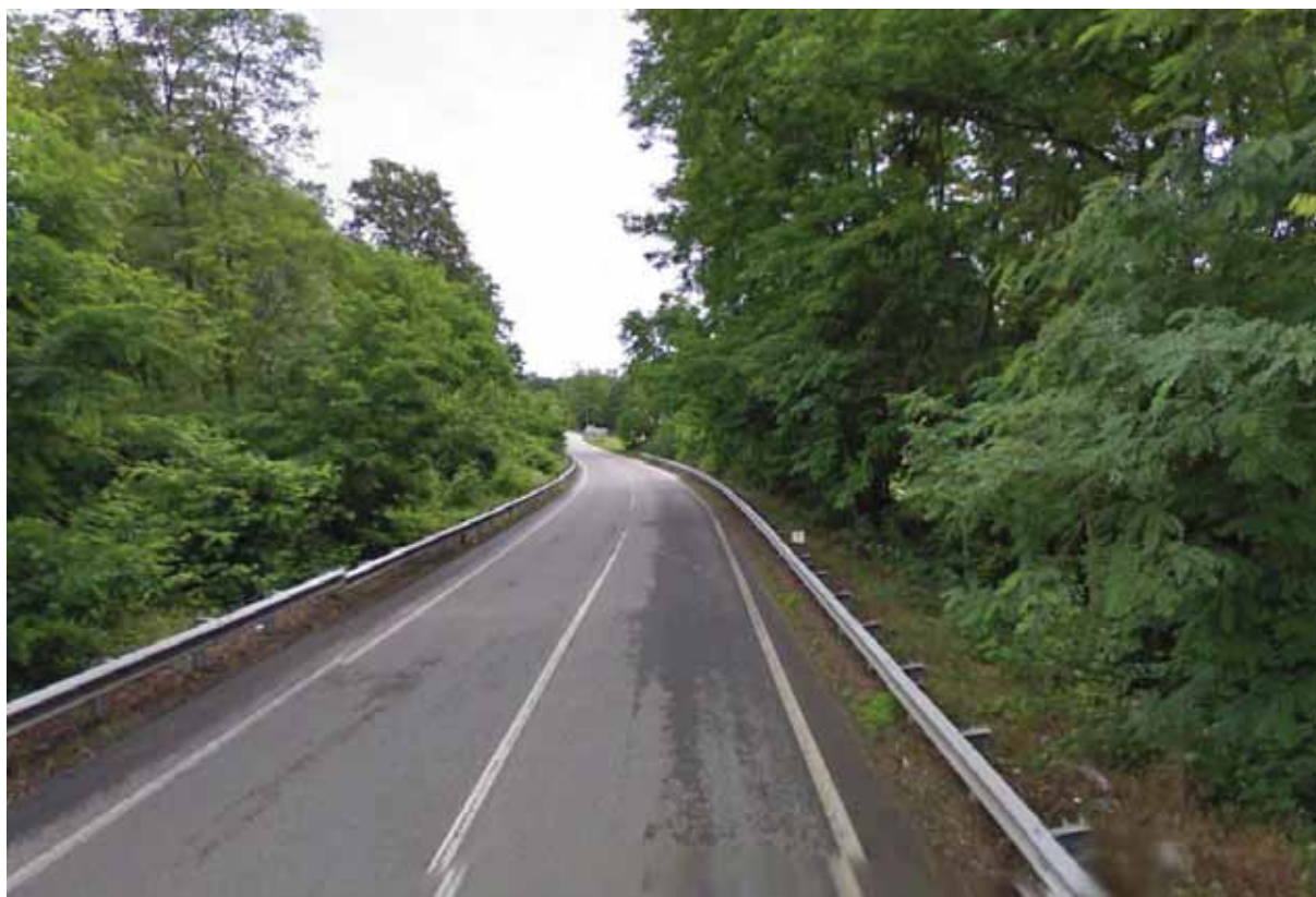
foto della SP28 lungo il tratto interessato - Google Maps
