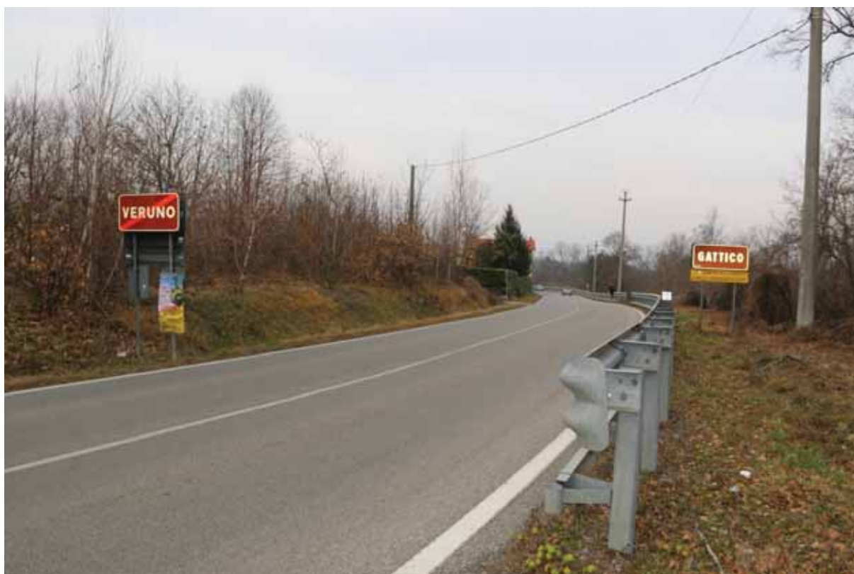
foto della SP 19 nel tratto interessato
