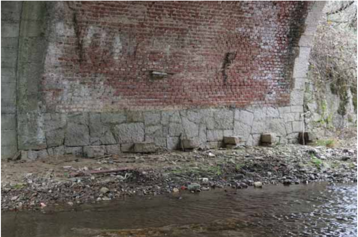
foto del sottopasso del Torrente Vevera
