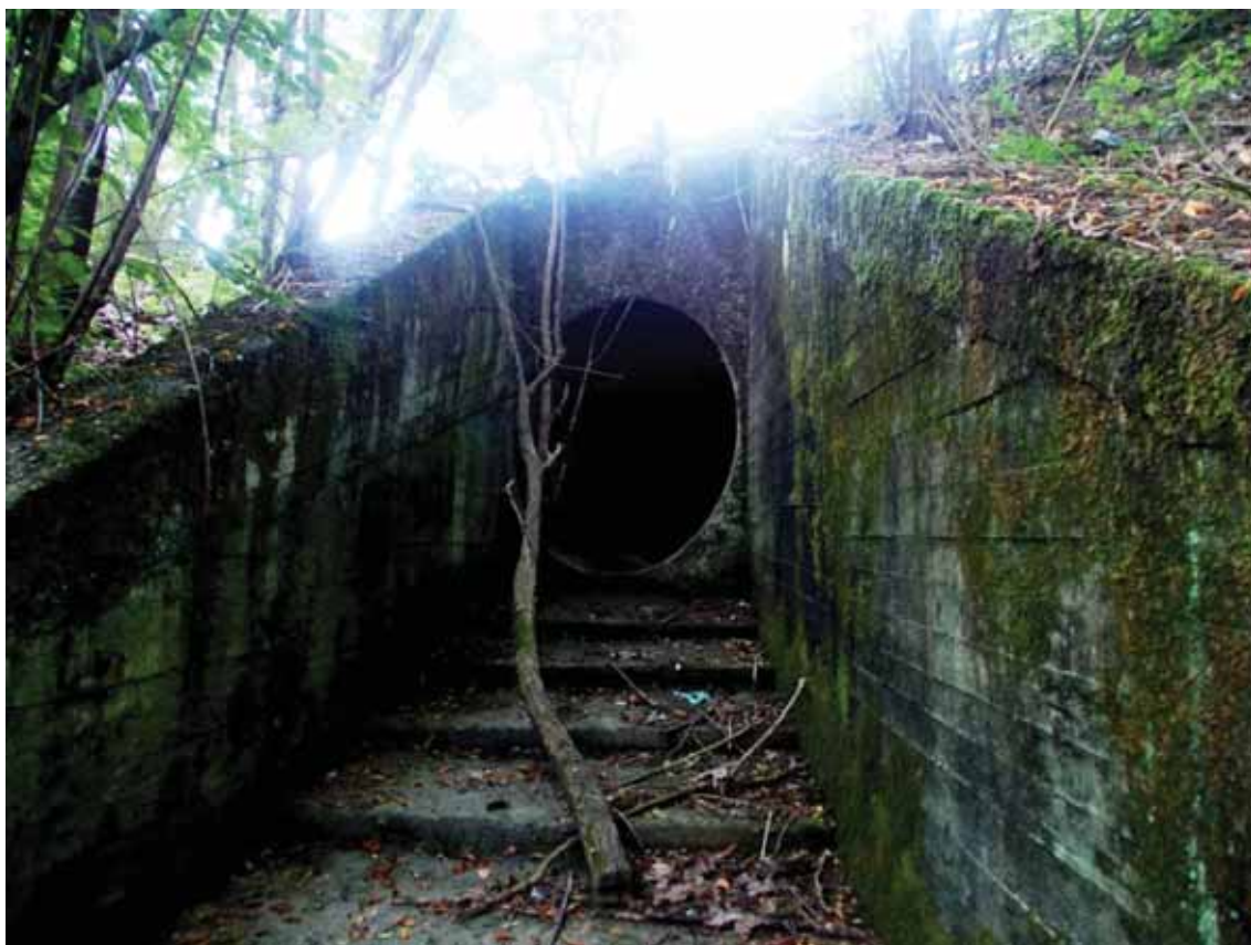
Foto del sottopassaggio esistente sotto la SS142
