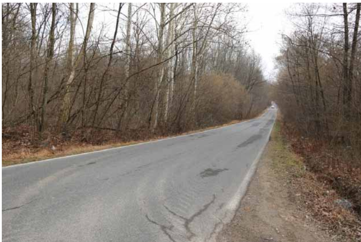
foto della SP84 nel tratto interessato
