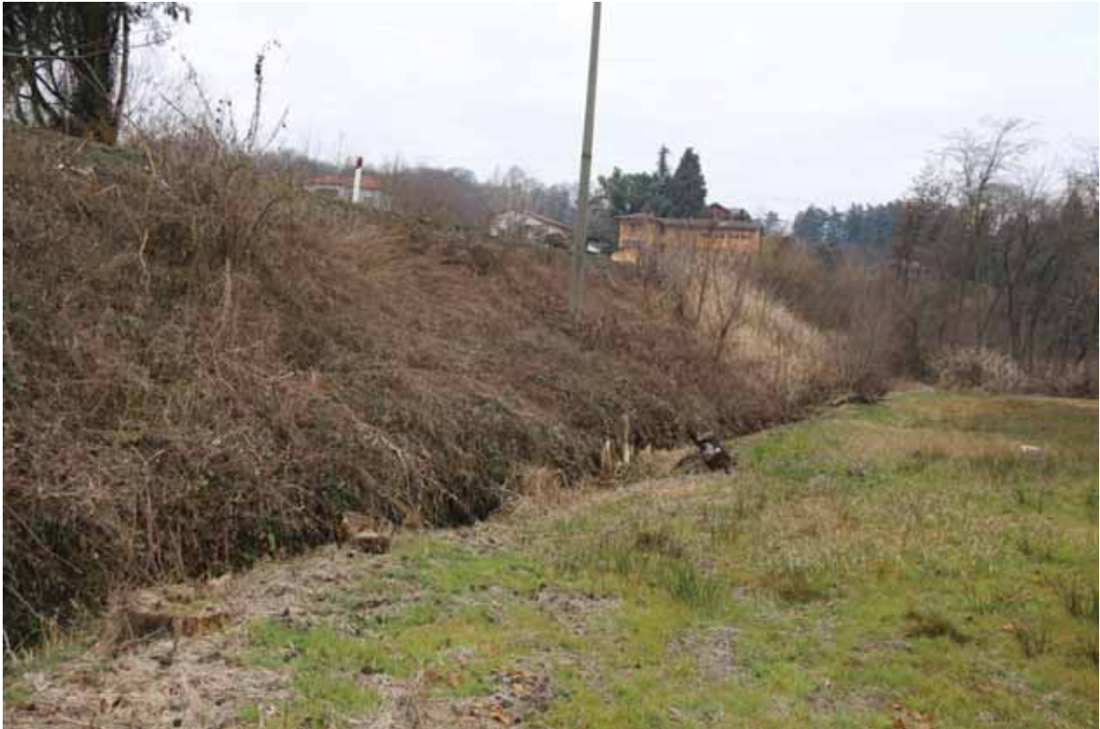
foto della zona di intervento
