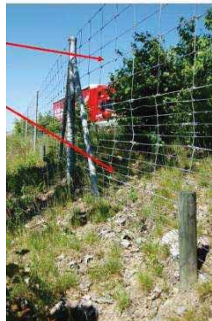
Figura 3.2.3 - Esempio di rete a maglia diversificata posta lungo una strada ad intenso traffico per evitare l'attraversamento
