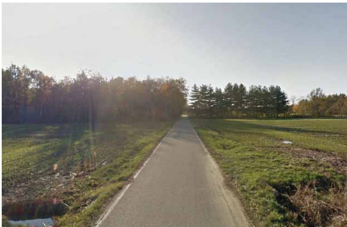
foto della SP105 lungo il tratto interessato - Google Maps
