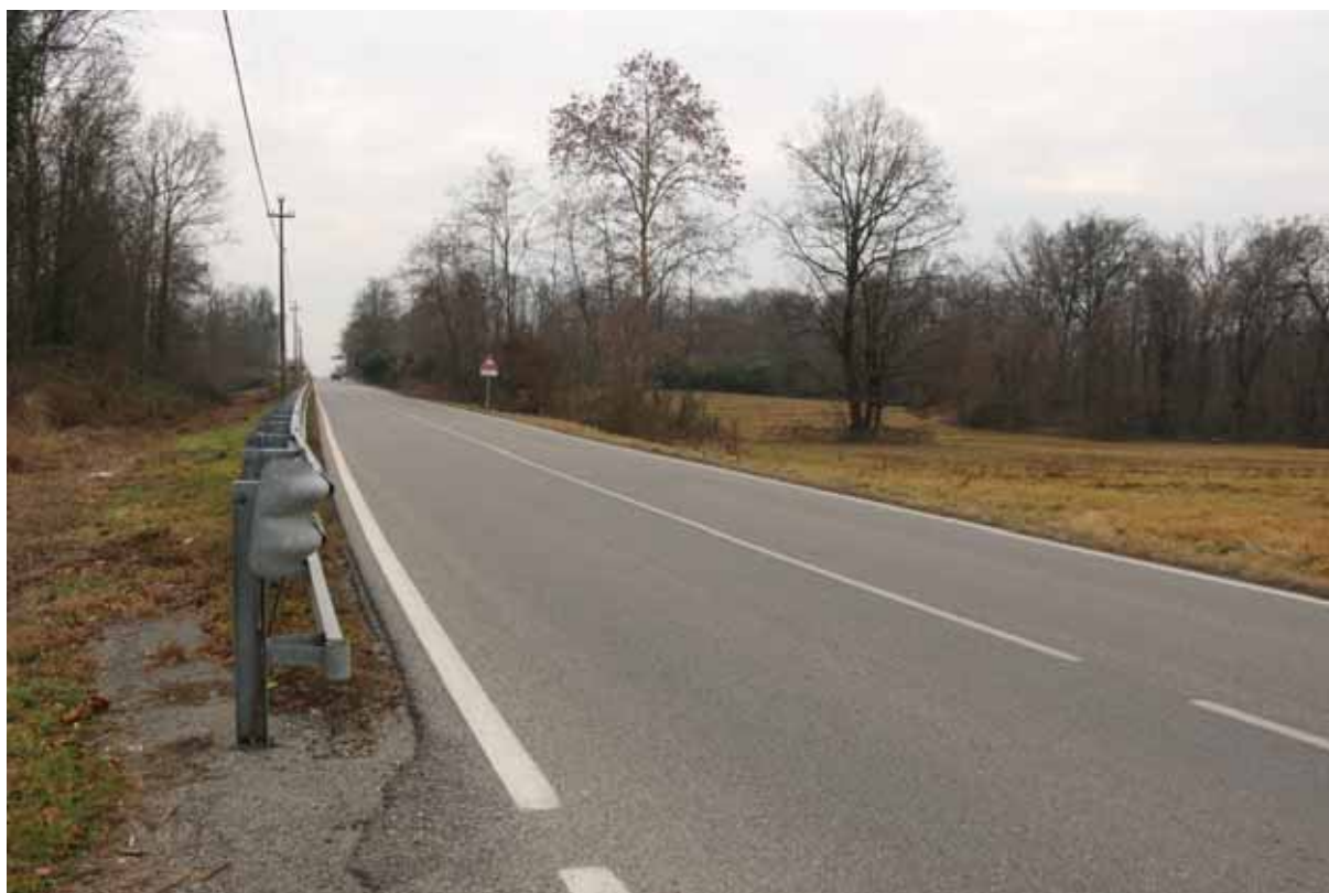
foto della SP 19 nel tratto interessato
