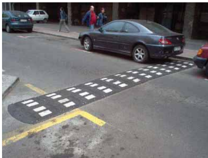
Figura 3.4.1.1 - Esempio di applicazione di dosso in gomma
