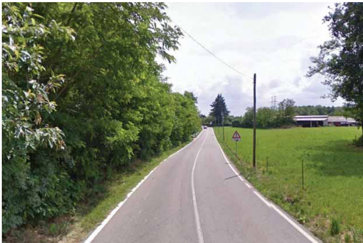
foto della SP166 lungo il tratto interessato - Google Maps
