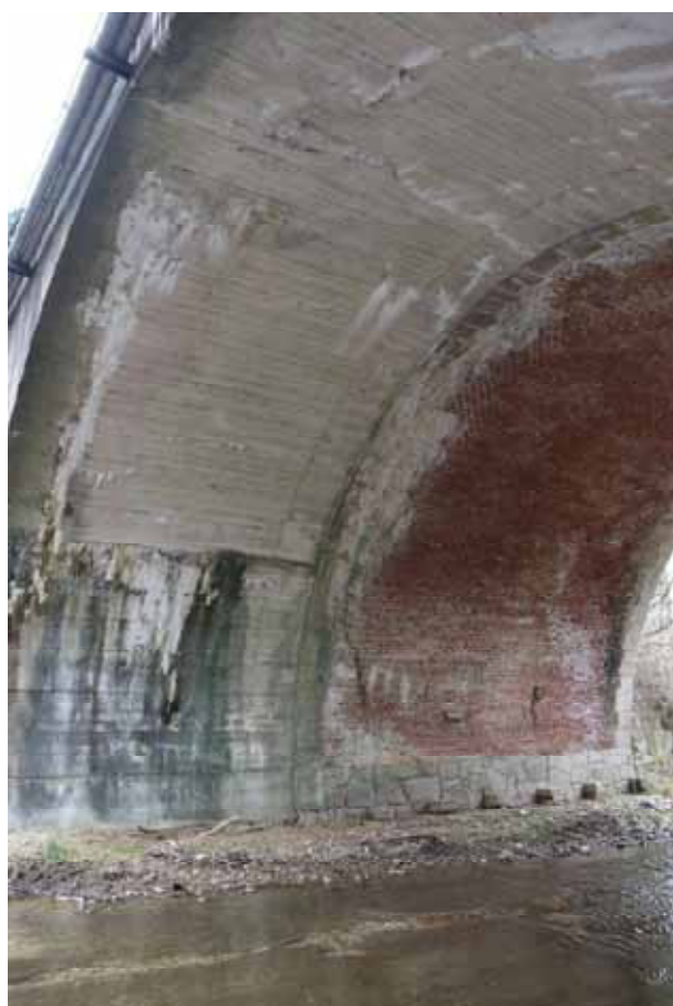
foto del sottopasso del Torrente Vevera
