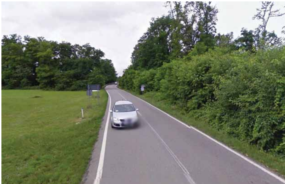
foto della SP28 lungo il tratto interessato - Google Maps
