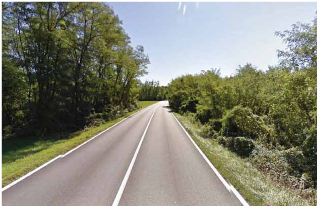
foto della SP156 lungo il tratto interessato - Google Maps
