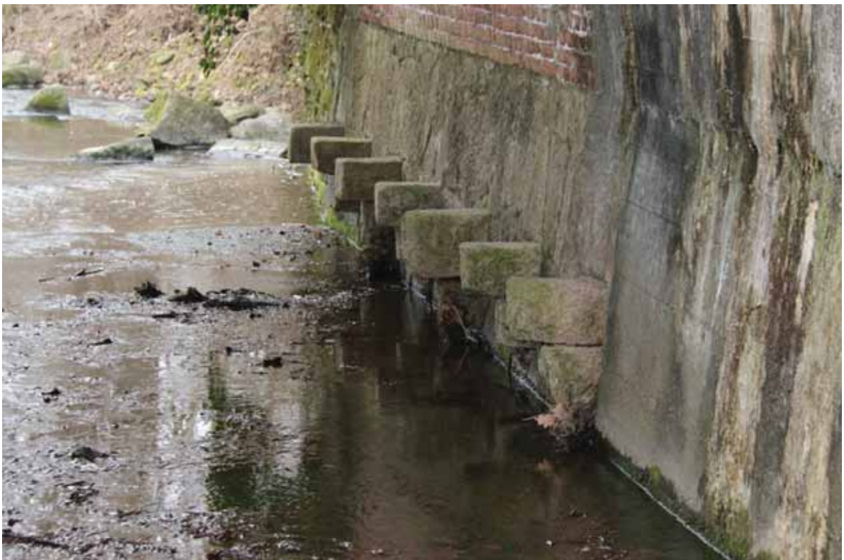
foto del sottopasso del Torrente Vevera
