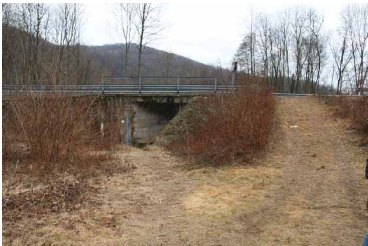
foto della rampa di accesso carraio da dotare di rete e cancello per impedire che la fauna selvatica la utilizzi accedendo alla sede stradale.
