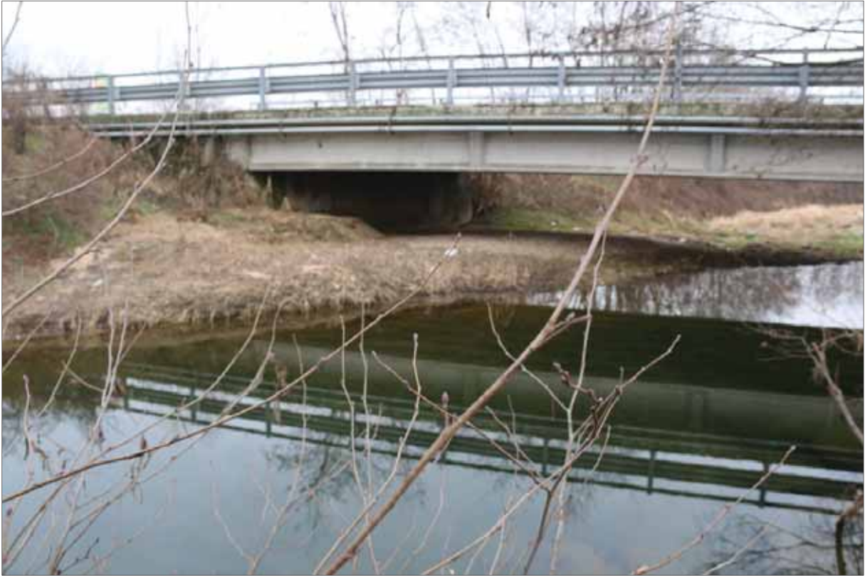
foto del punto in cui il torrente Terdoppio sottopassa la SP17
