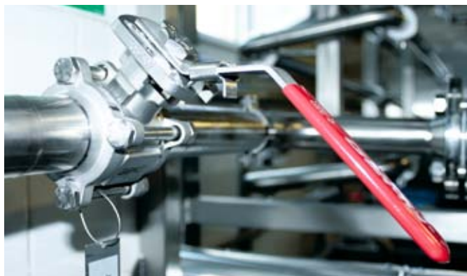
Detail kulového kohoutu 711 s navařovacími koncovkami dle DIN 11850 ř.2 po orbitálním navaření.
