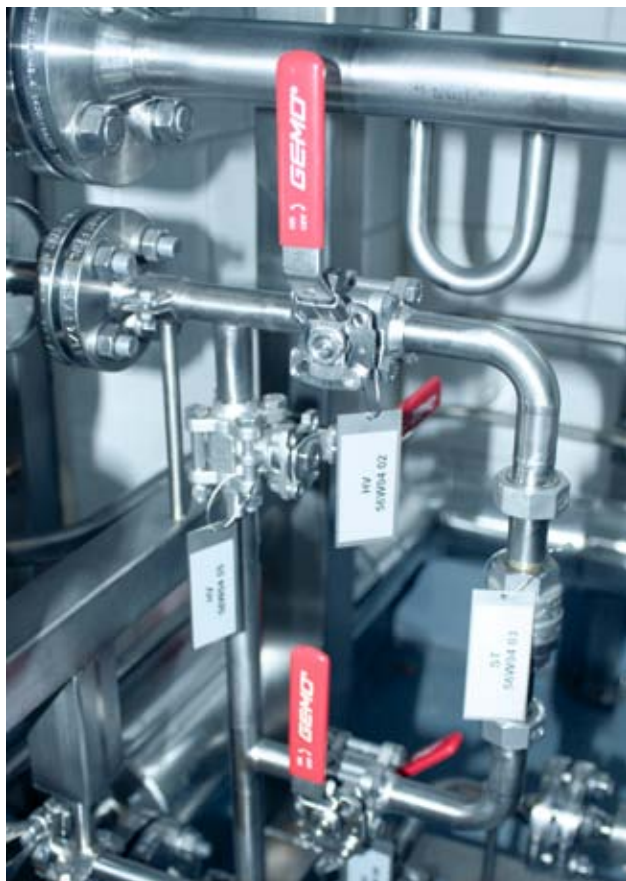
Přepouštěcí uzel s ručními kulovými kohouty 711.
