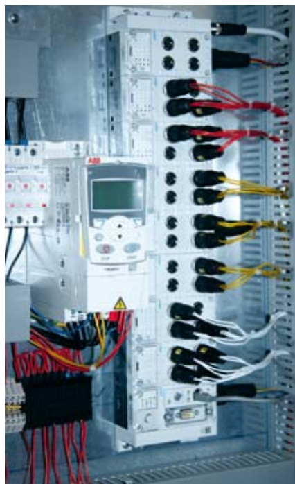
Detail CPX – desky vstupů a výstupů.
