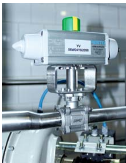
Kulový kohout s jednočinným pneumatickým pohonem DAPS s konzolou pro možnost izolace potrubí.
